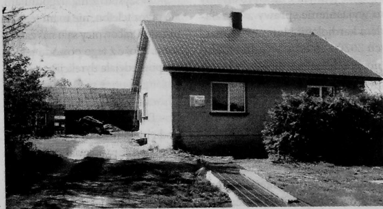
Dom rodziny Relugów z nowym dachem, remont w środku jeszcze trwa
