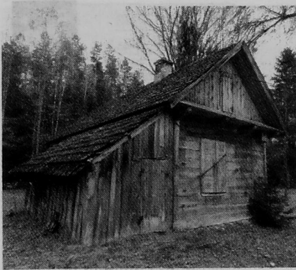
Jedno z zabudowań Wierszalina, stan obecny
