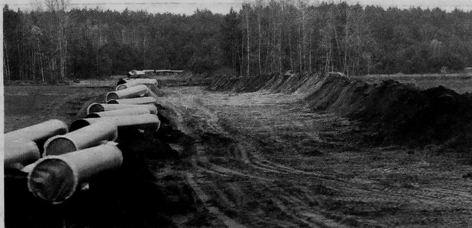
Budowa gazociągu Polska – Litwa, którego południowa odnoga ma 160 kilometrów, weszła na pola gminy Nowogród, na których powstanie prawie 14-kilometrowy odcinek. Fot. Gmina Nowogród
