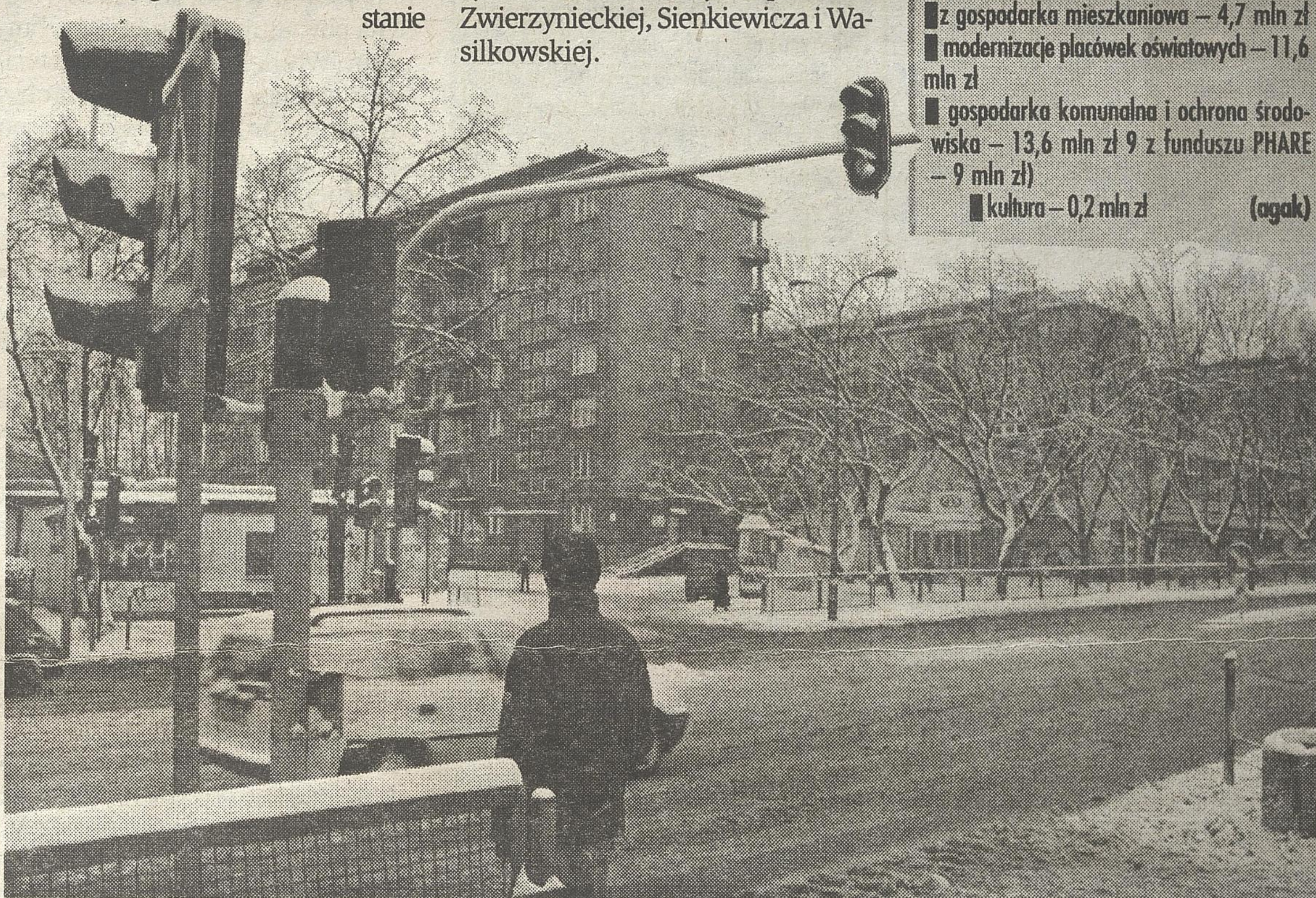
Już pod koniec kwietnia zostanie wykonane przebiecie ulicy Częstochowskiej na odcinku od Lipowej do alei Piłsudskiego
