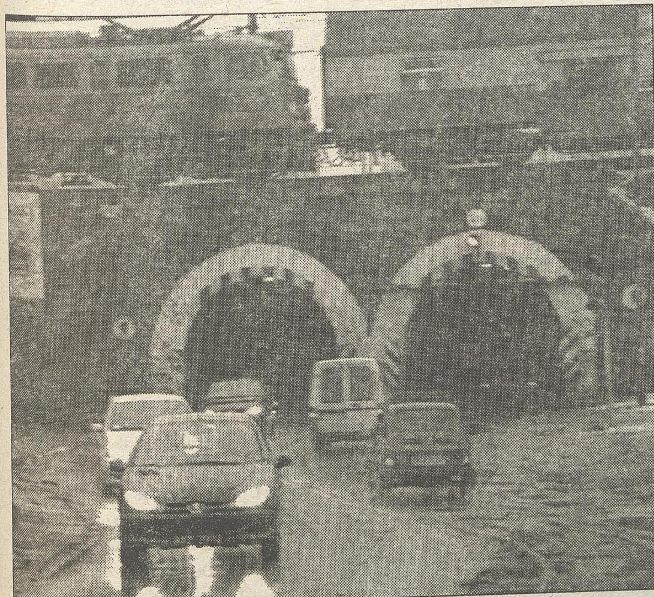
W sierpniu zostanie zamknięty stary tunel pod torami przy ul. Hetmańskiej, a nowy nie będzie jeszcze gotowy
