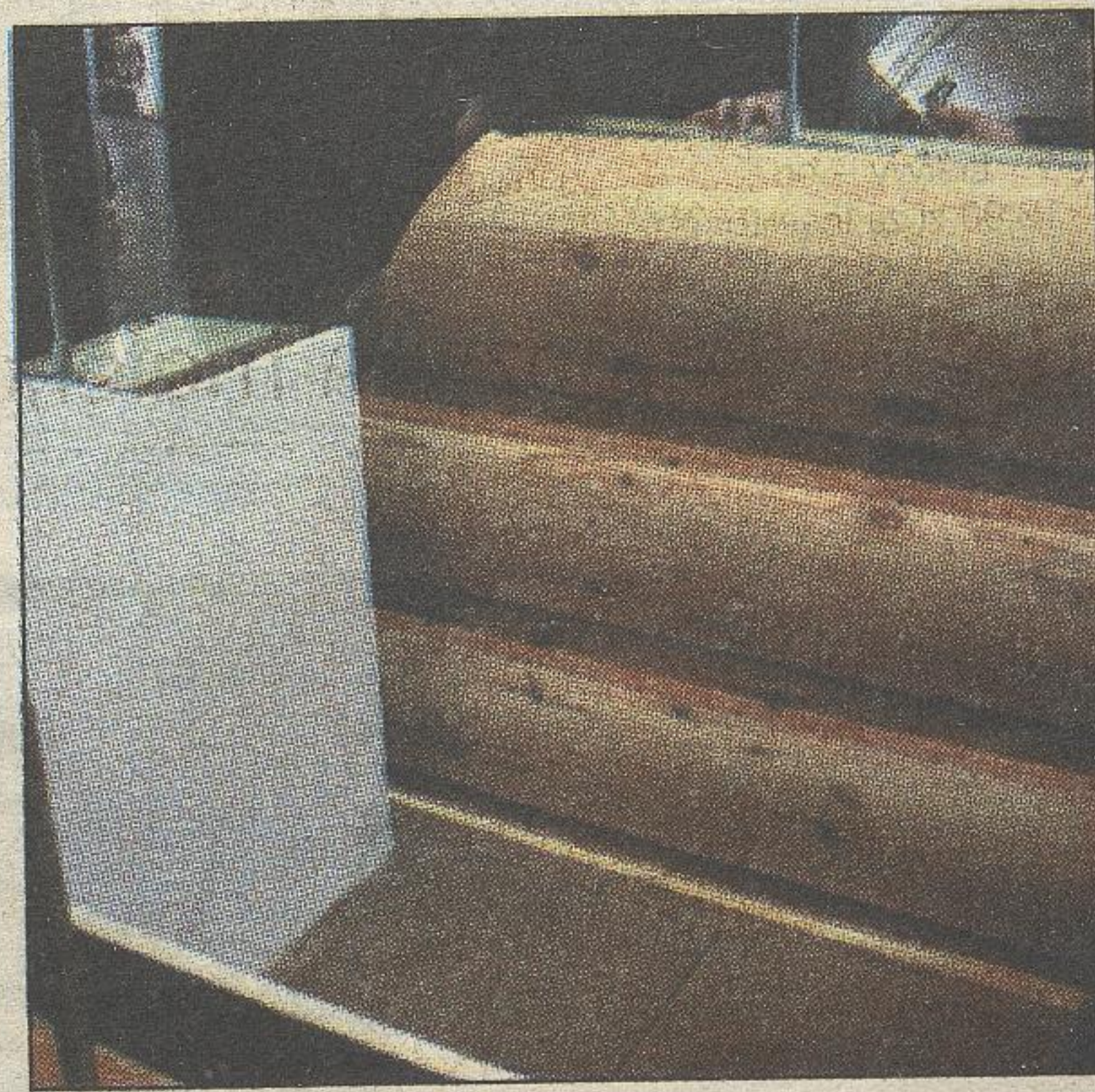
Przekrój przez ścianę wykonaną w systemie M-Bal pokazujący dwa warianty wykończenia ściany od wewnątrz: ścianę zarówno z zewnątrz jak i wewnątrz wykonaną z bala prefabrykowanego, oraz ścianę przystosowaną od wewnątrz do wykończenia wnętrza płytą gipsowo-kartonową
