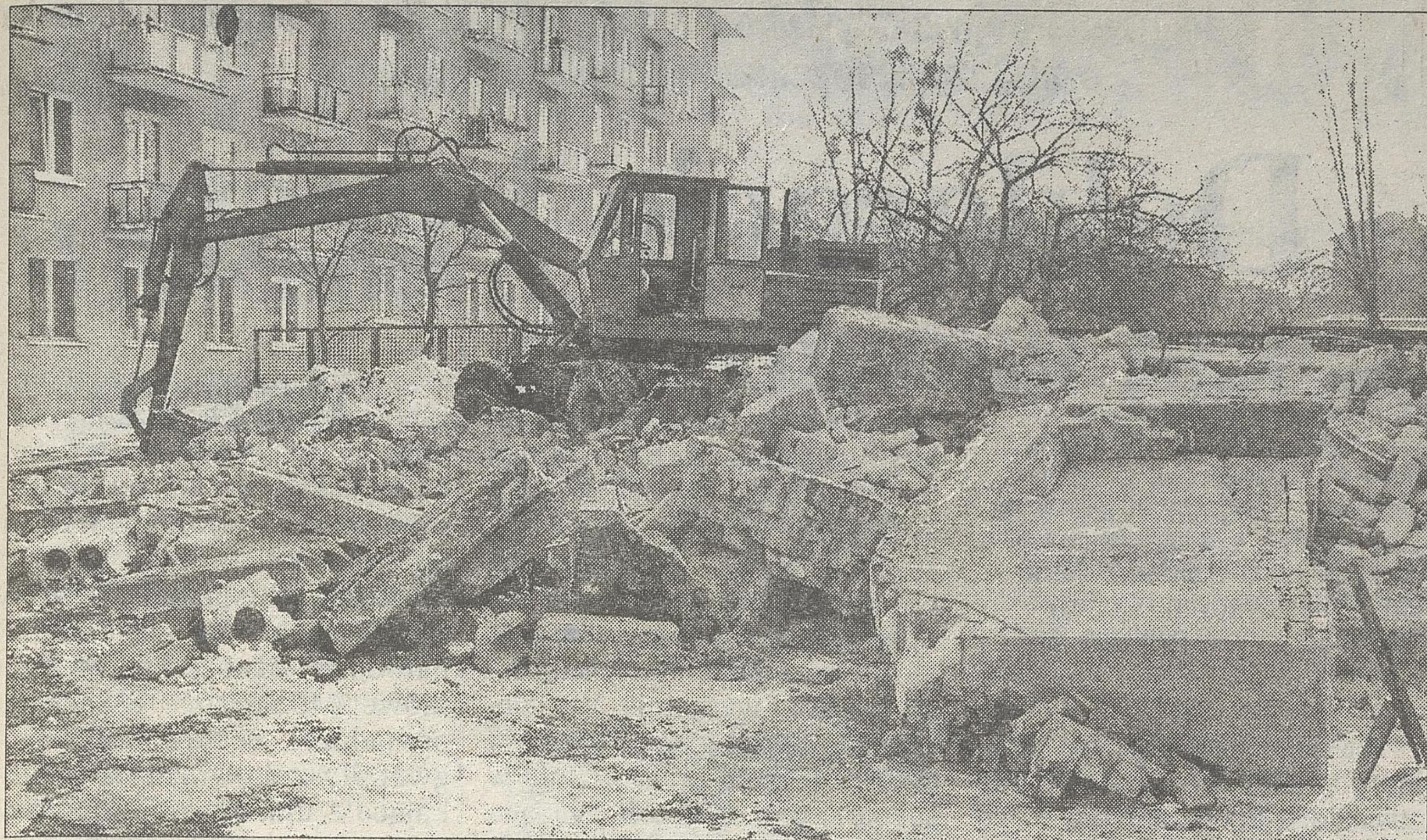
Przy al. Piłsudskiego trwa rozbiórka starych budynków. Już w październiku będzie tędy przebiegać nowy odcinek ul. Częstochowskiej.
