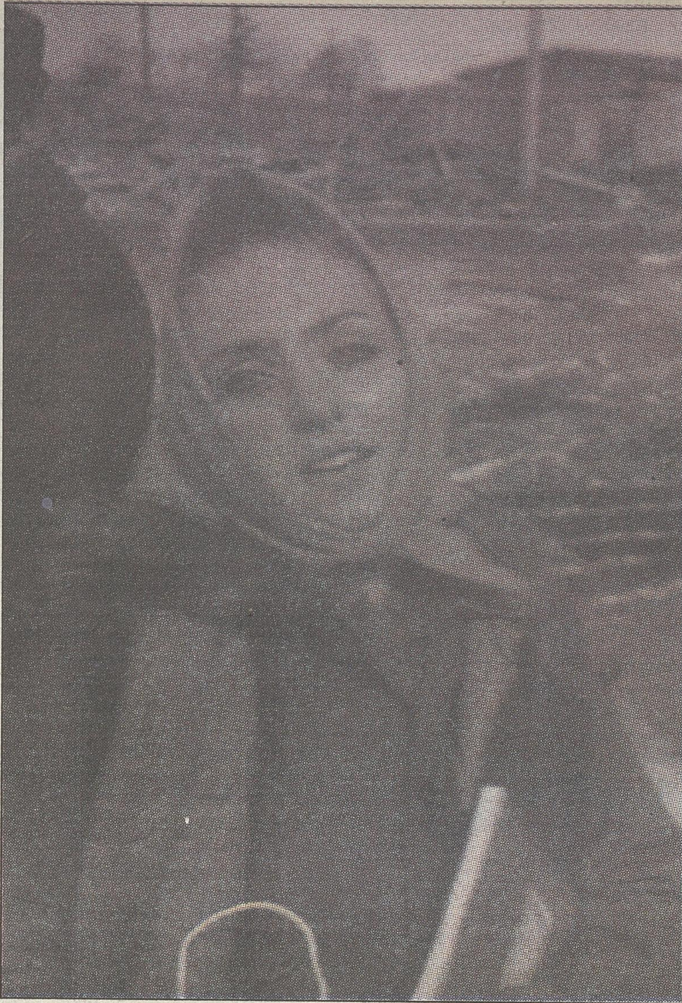
Elżbieta Kępska na stażu. Jest luty 1969 roku, budowa słynnych betonów elckich.
