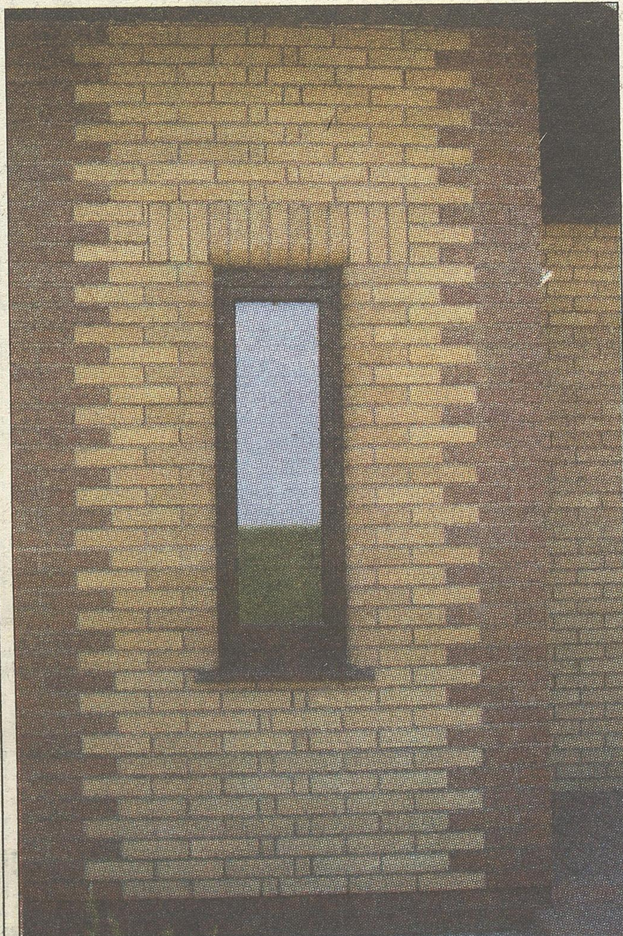
Architekt już w projekcie powinien określić ilość i rodzaj materiału na elewację. Efekt delikatnego melanżu uzyskamy stosując cegły z kilku palet.
