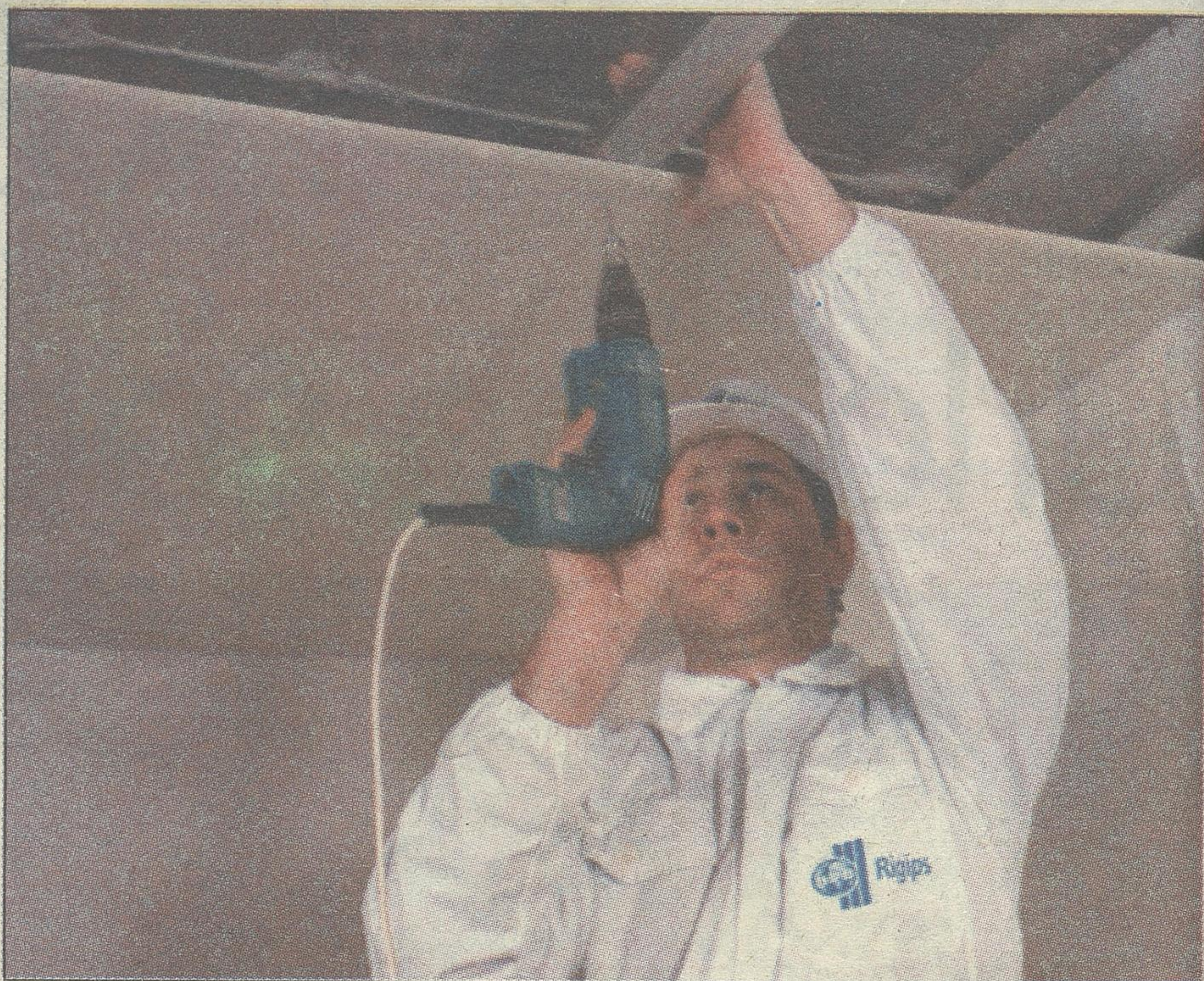
Poprawnie wykonana ścianka lub sufit z płyt g-k nie tylko prezentuje się estetycznie, ale i współpracuje z konstrukcją budynku.
