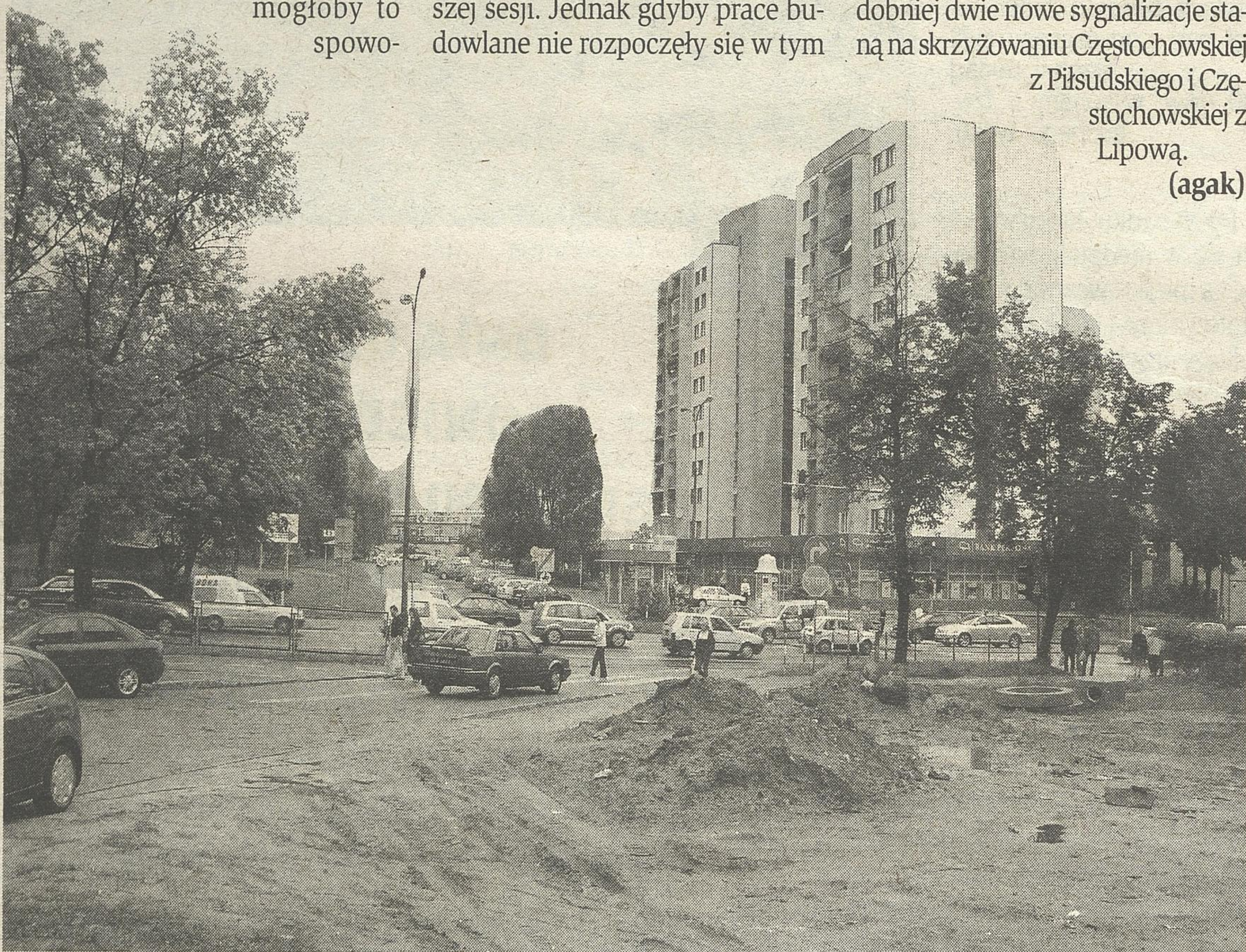
Przy ul. Częstochowskiej trwają już prace kanalizacyjne i przygotowywane jest uzbrojenie. Jednak kiedy rozpocznie się właściwa część inwestycji – jeszcze nie wiadomo.
