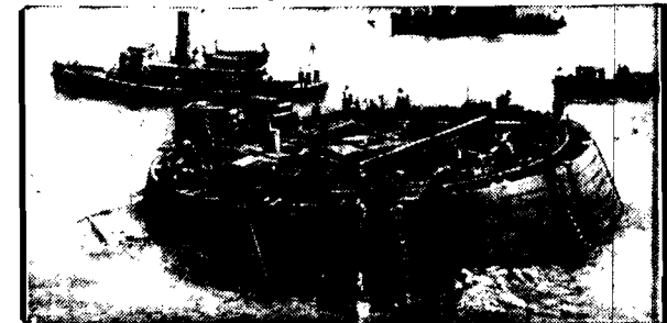
Wielomilionowe miasto Chicago odczuwa dotkliwy brak wody do picia. W celu zapobieżenia temu brakowi umieszczono na jeziorze Michigan pływającą stację pomp, która czepiając się dna, wyciąga wodę.
