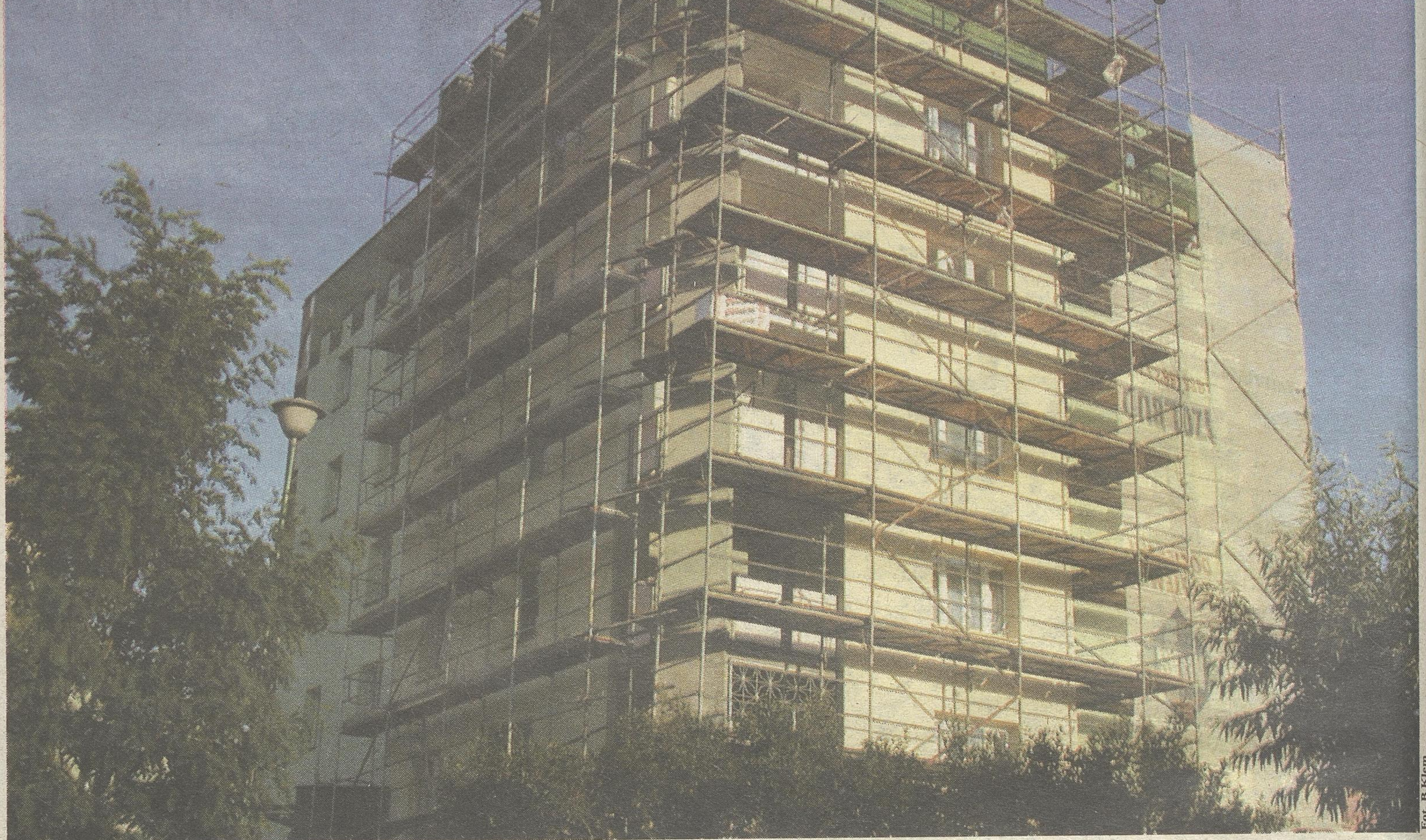
Docieplanie budynków wielorodzinnych Spółdzielni Mieszkaniowej Słoneczny Stok w Białymstoku
