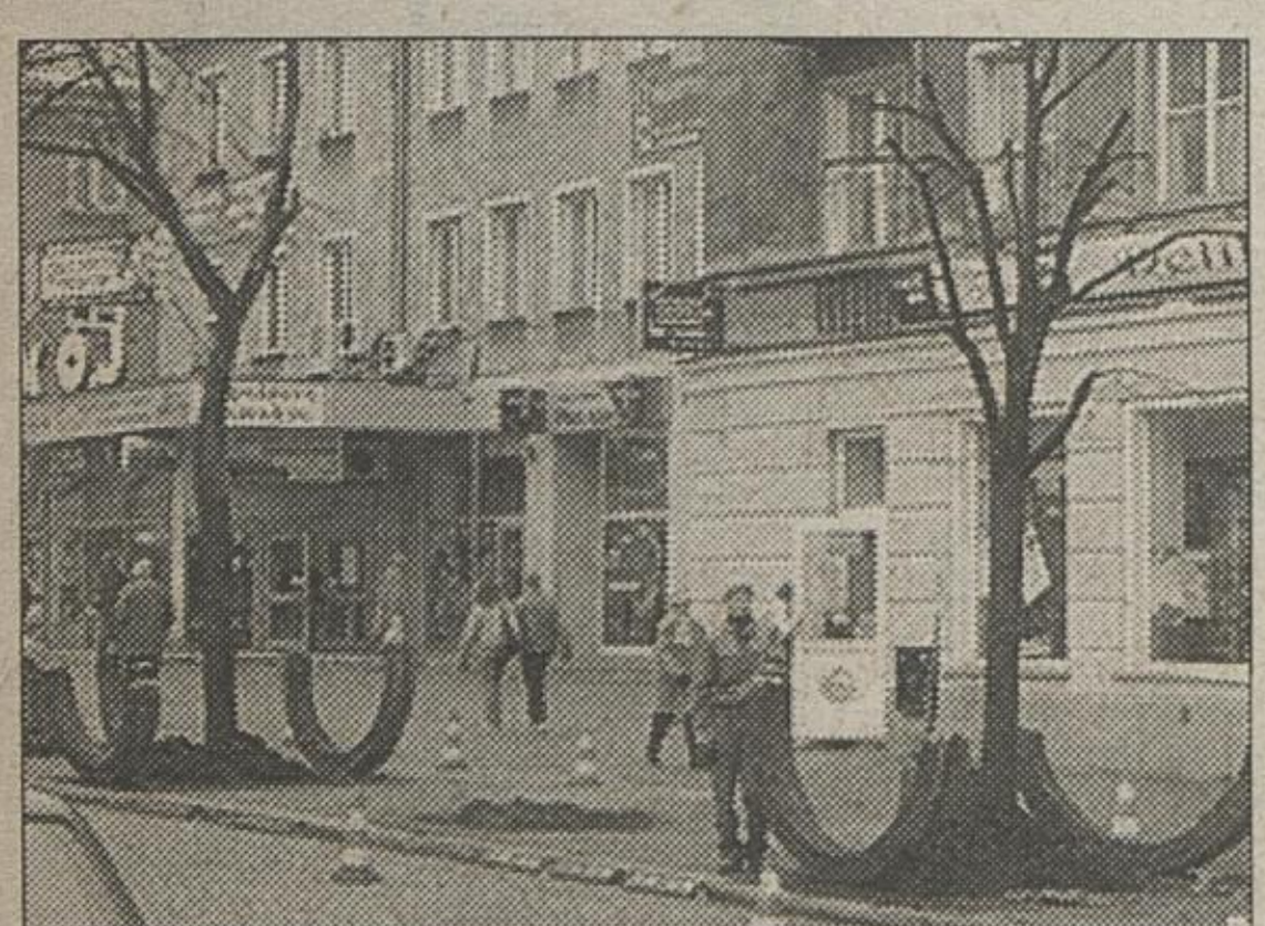
Rozpoczęto usuwanie betonowych konstrukcji wokół lip. To kolejny etap leczenia drzew rosnących w centrum Białegostoku
