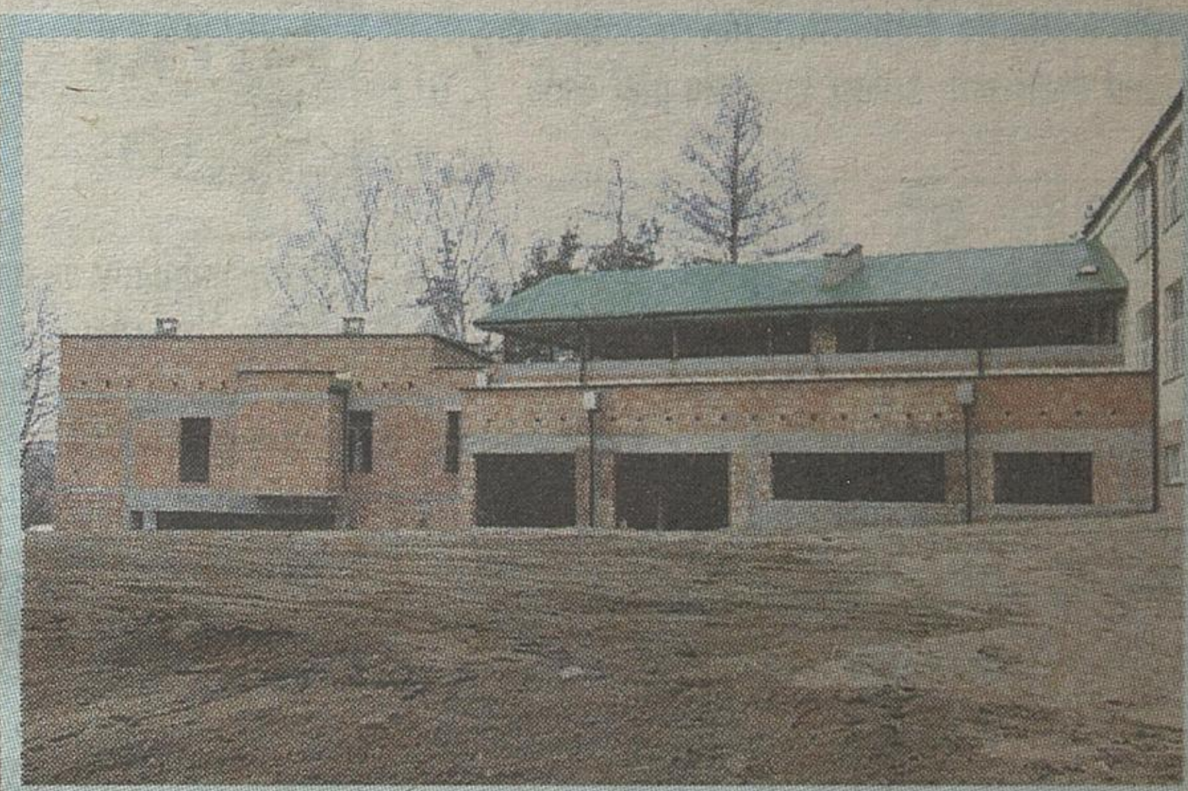
Trzecie miejsce zajęć to Zespół Szkół w Siemiatyczach – część tego budynku może w przyszłości stać się główną siedzibą NSW
