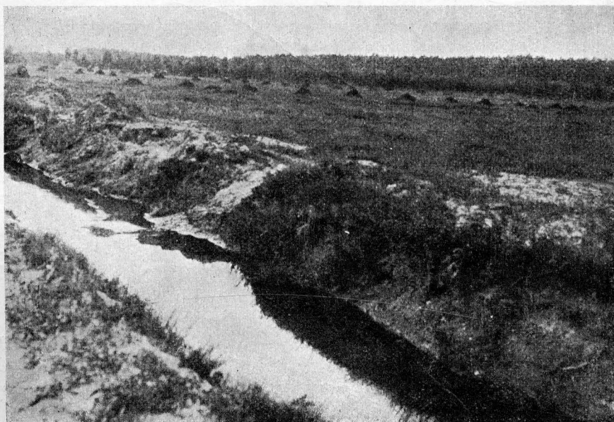
Kanał odwadniający przy meljoracji łąk w Chronowie
