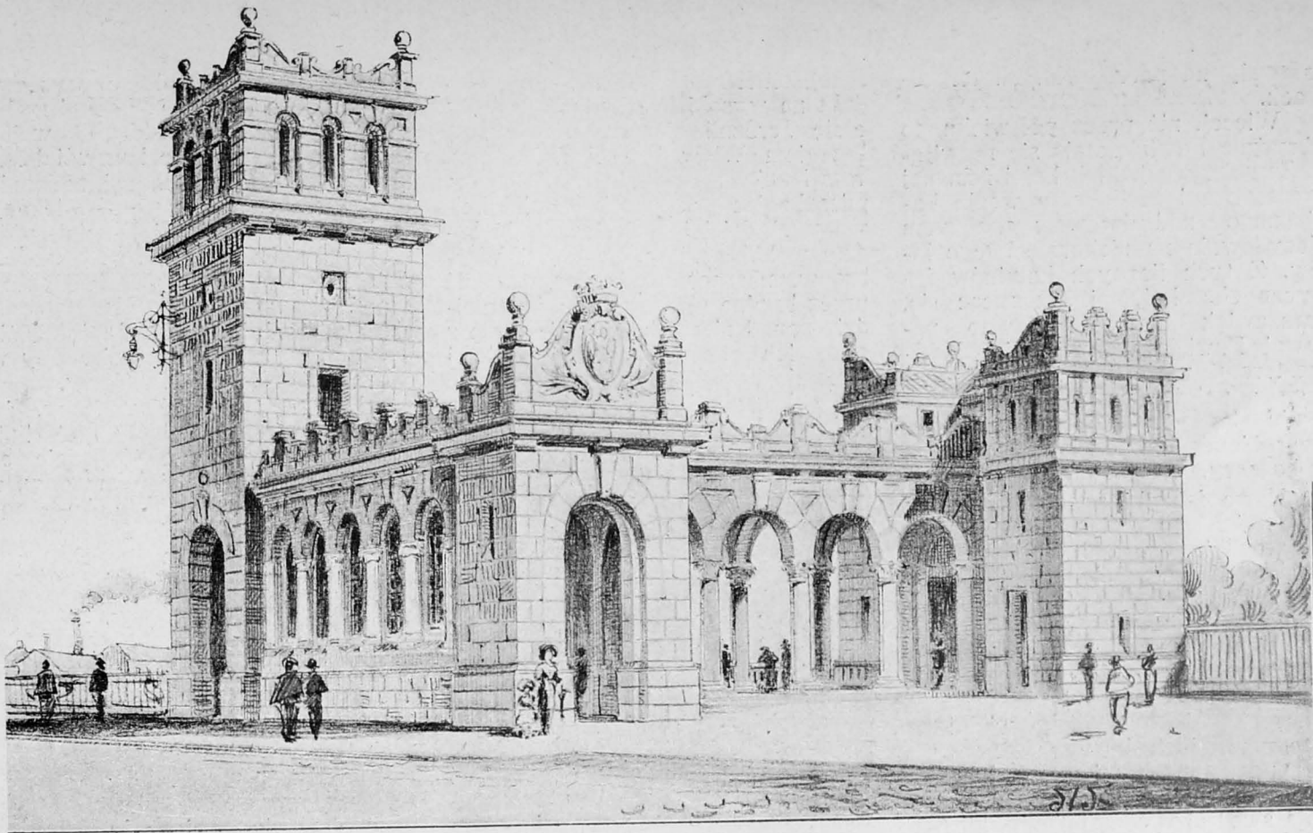
Przy wjeździe na wiadukt staną na ścianie oporowej podług projektu p. St. Szyllera pawilony z kolumnadą i basztami, mieszczące schody i windę między dolną a górną aleją Jerozolimską.
