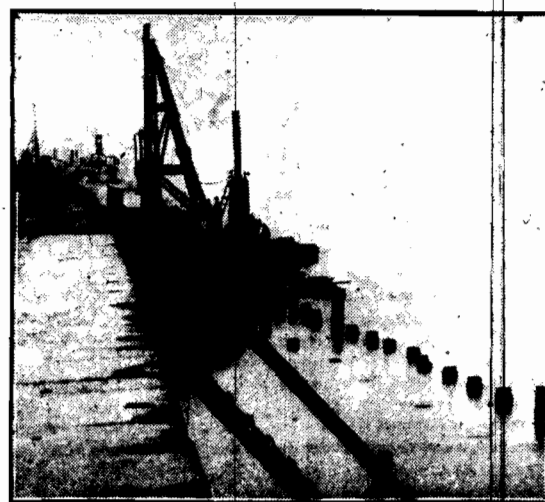
Wbijanie pali poniżej mostu Kierbedzia. Do paliw tych ma sięgnąć nowy rozszerzony bulwar wzdłuż brzegów warszawskich.
