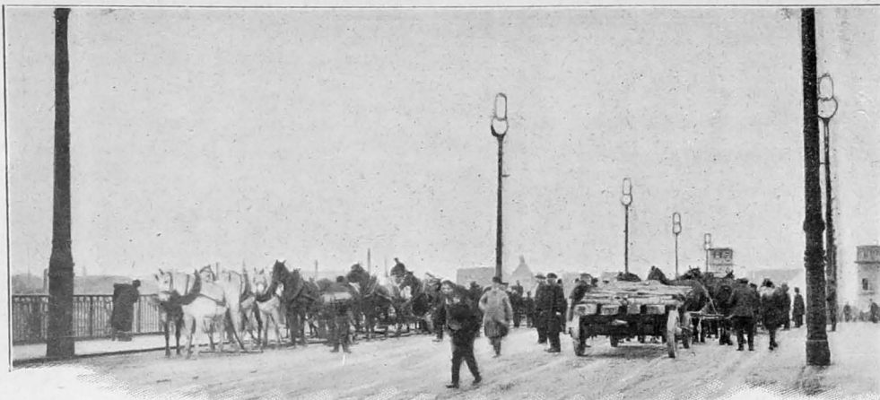
Urządzone na trzecim moście próby dynamiczne i przez obciążenia ruchowe dały wyniki dobre, świadczące o wytrzymałości mostu i... o cierpliwości warszawian. Fot. L. Kowalski.
