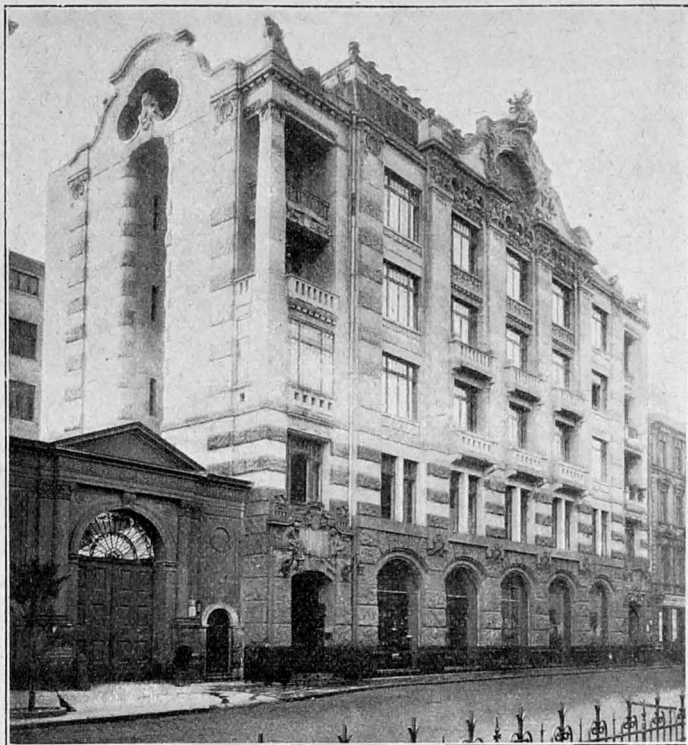
Gmach zakładów gazowych przy ul. Erywańskiej № 3.
