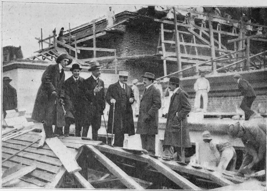
Budowa gmachu teatru nowoczesnego.
