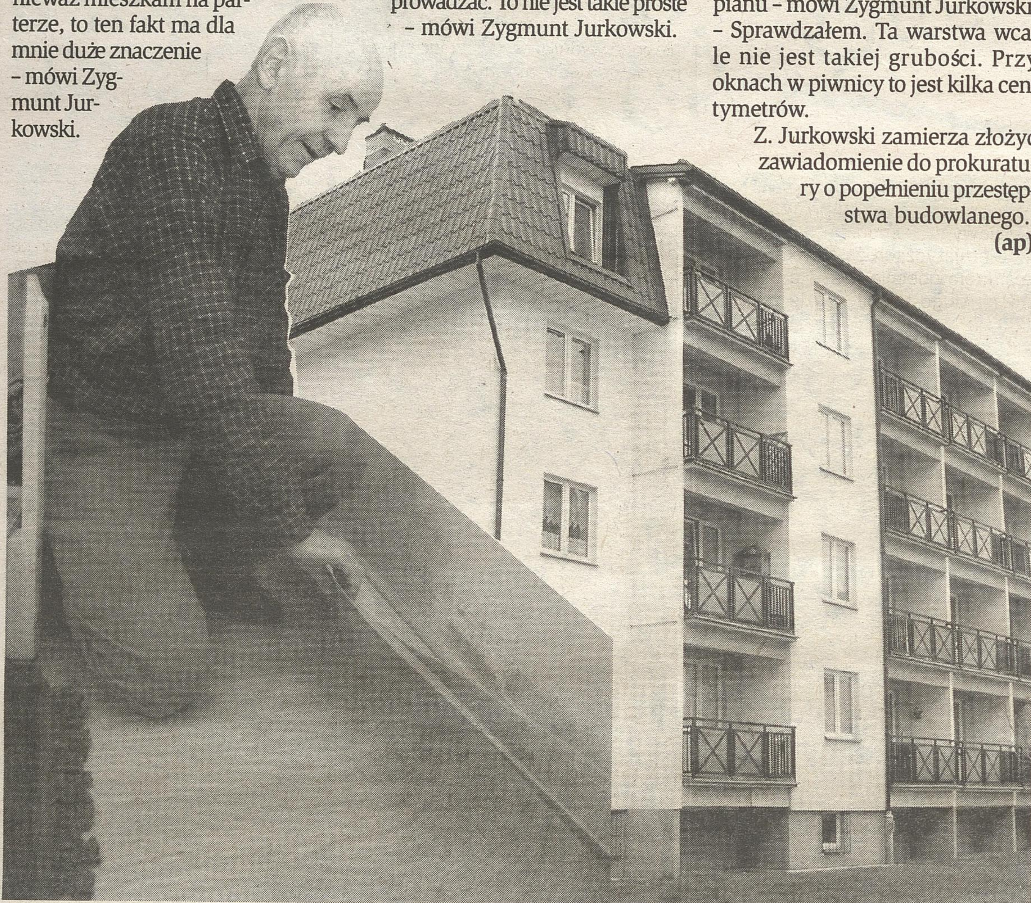
– Wilgoć na ścianie w moim mieszkaniu jest już od kilku lat. Nie wiem już co mam robić, bo KTBS nie przyznaje się do tego, że popełniło błędy podczas budowy bloku – mówi Zygmunt Jurkowski, mieszkaniec budynku przy ul. Pietkiewicza 5.
