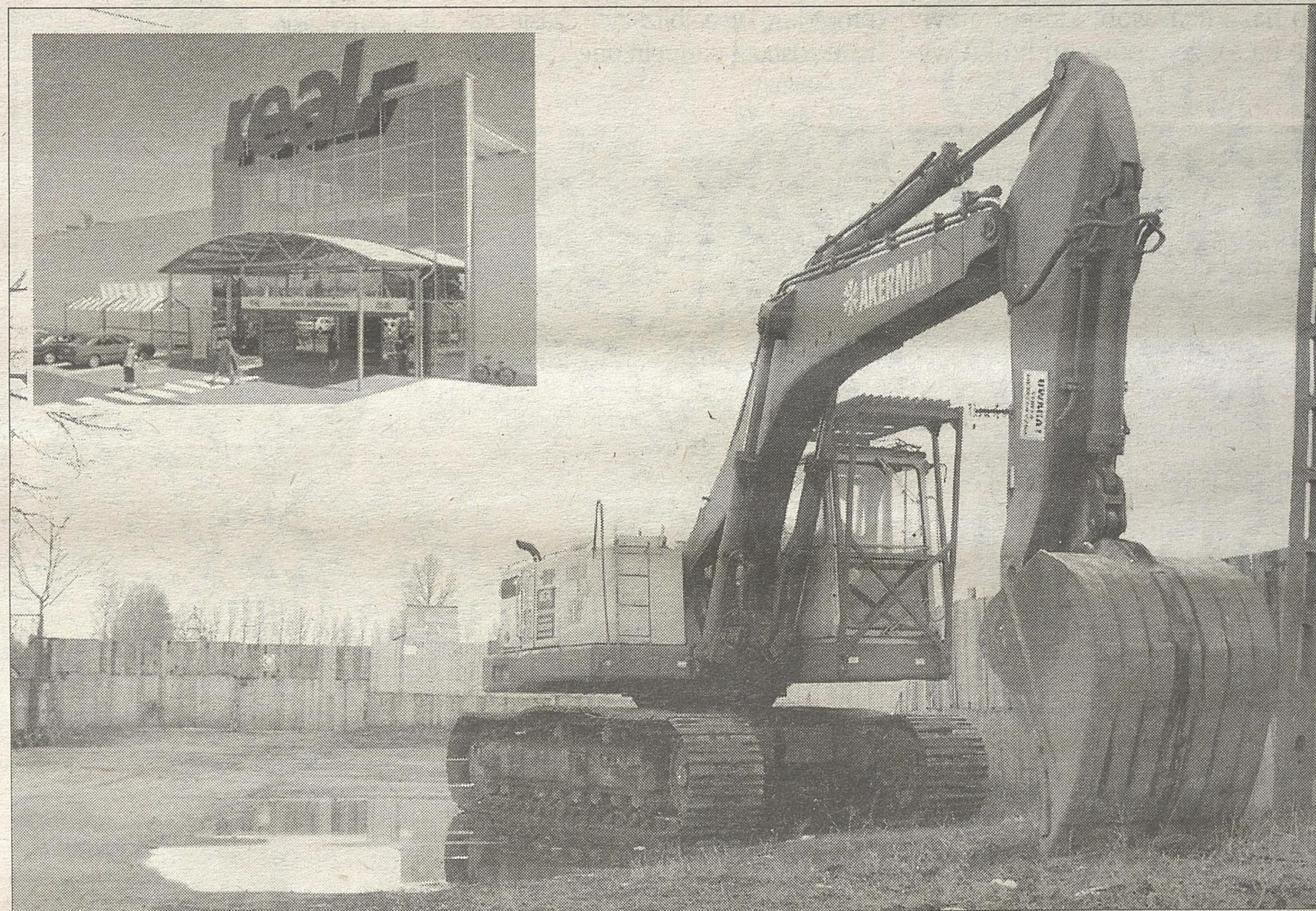
Przy ul. Hetmańskiej ogrodzono już teren, gdzie wkrótce rozpocznie się budowa hipermarketu Carrefoure. Tymczasem być może jeszcze w tym roku na osiedlu Zielone Wzgórze powstaną trzy hipermarkety, m.in. Real (na małym zdjęciu).
