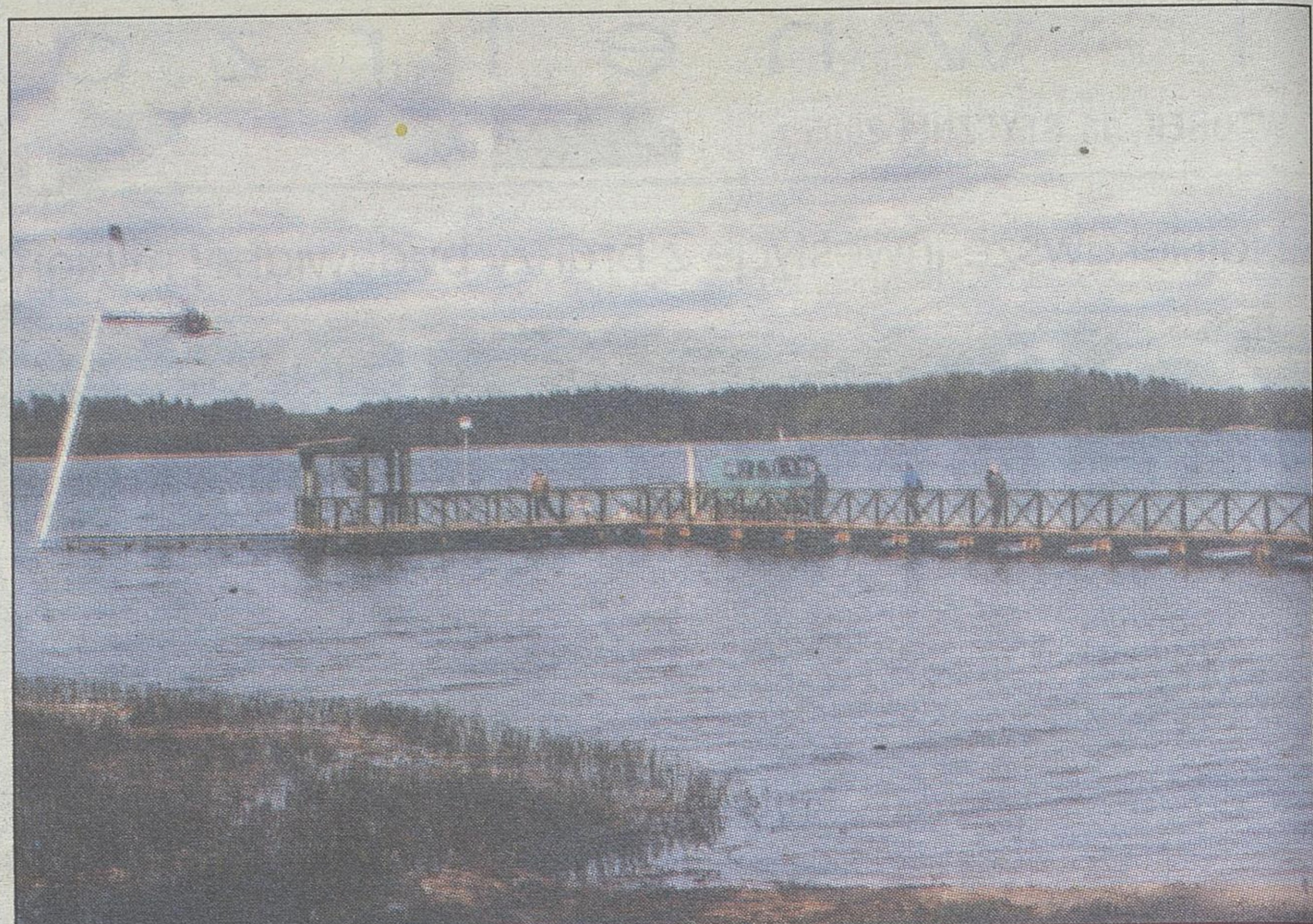
Teren inwestycji obejmujący jezioro wynosi 63,5 tys. mkw. Na tej powierzchni znajdują się urządzenia wyciągu i dwie strefy do pływania dla dzieci i dorosłych oddzielone mołem.
