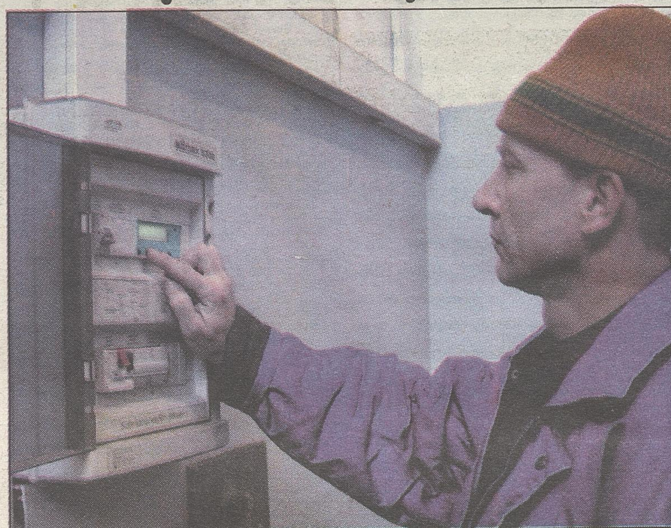
Serce pieca: sterowanie pracą kotła odbywa się w tym miejscu – prezentuje Edward Sawicki z firmy Refleks.
