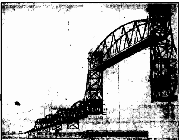
Nowy most w Newportie, który może przepuszczać pod swymi prze- słami największe parowce oceaniczne, jest istnym cudem nowoczesnej techniki.
