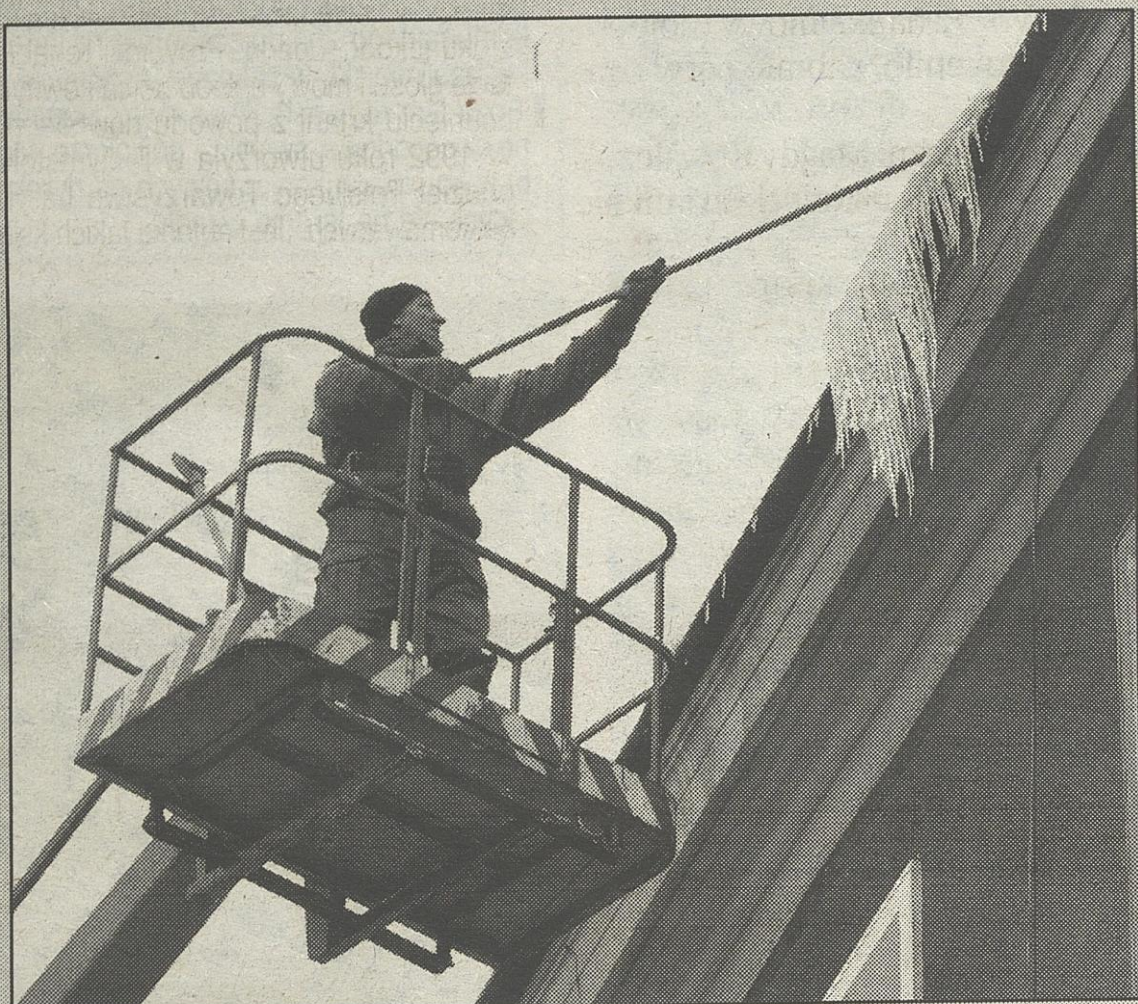
Zanim sople lodowe zaczną same spadać na głowy przechodniów, trzeba je usunąć. Do oczyszczania dachów wysokich budynków konieczne jest użycie podnośnika oraz drągów, którymi strąca się lodowe zwisy.
