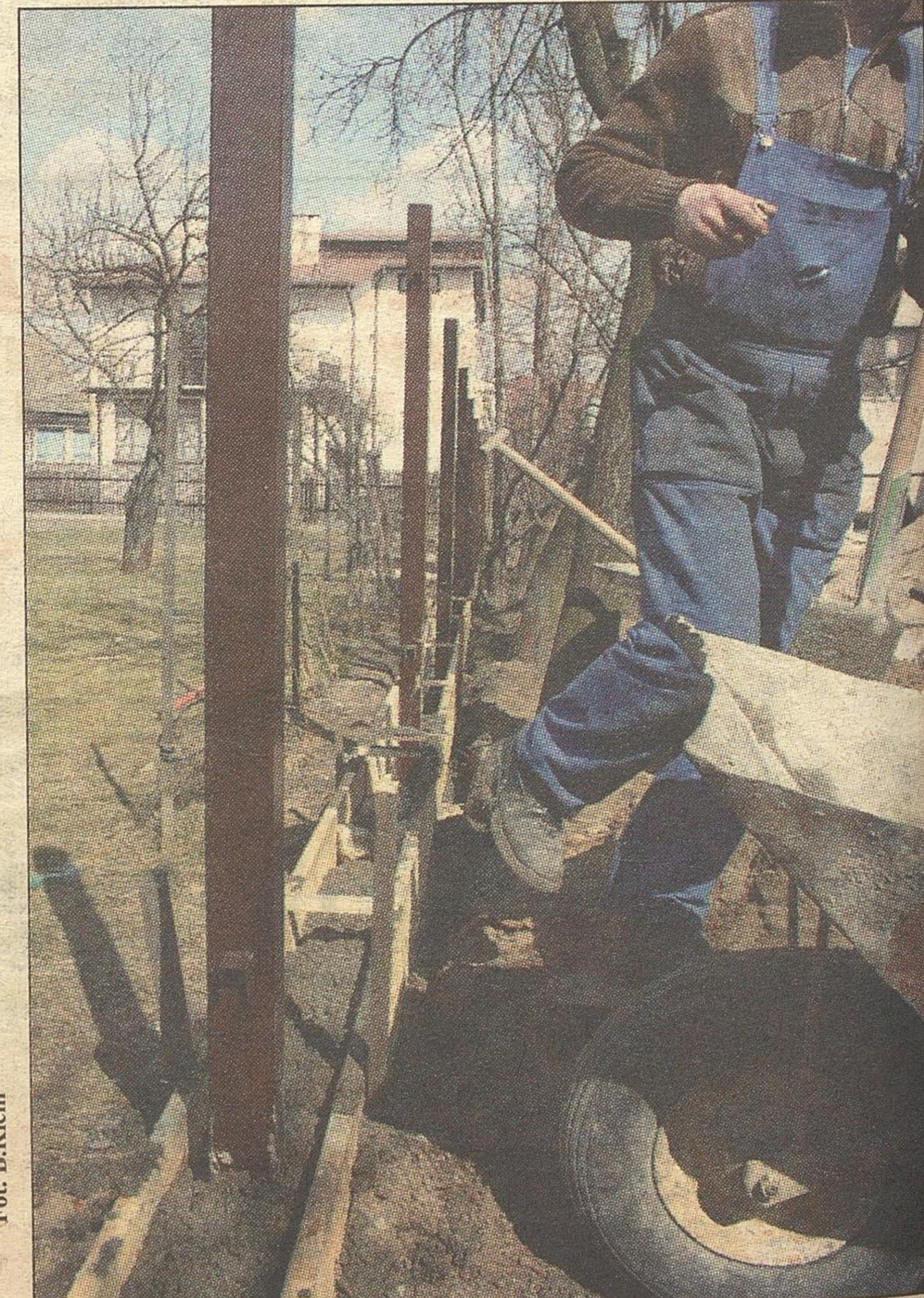
Każde ogrodzenie murywane powinno mieć fundament. Dla ochrony przed niszczącymi skutkami przemarzania gruntu, fundament pod ogrodzenie pełne lub ażurowe z podmurówką trzeba zagłębić na 80-120 cm
