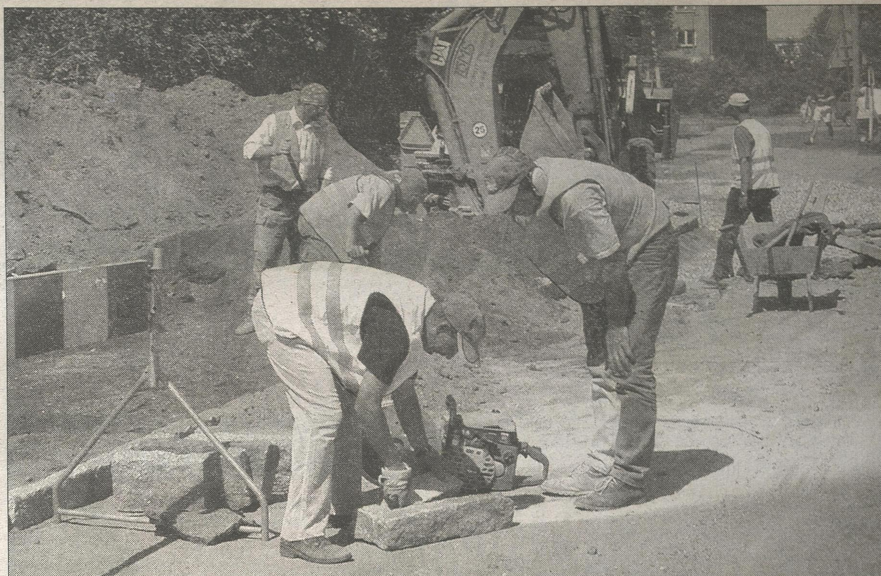
Na ulicy Hetmańskiej trwa poszerzanie ulicy. Już od dziś drogowcy zaczną układać tam nowy asfalt.
