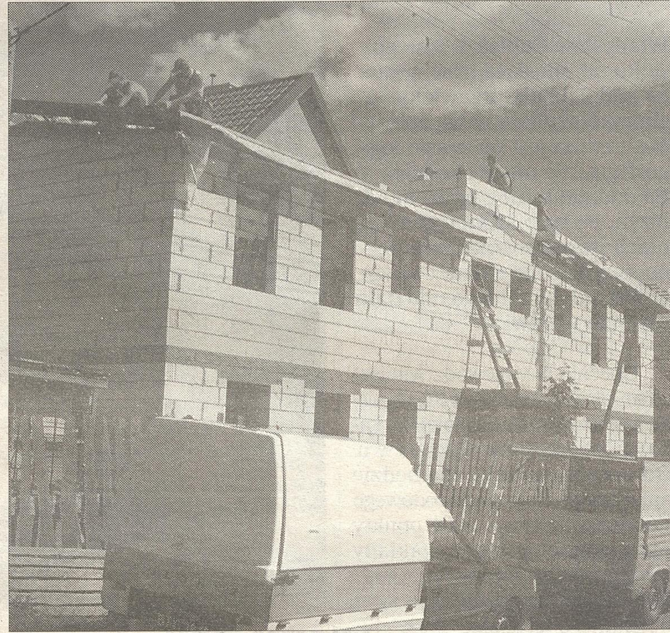
Tak budowa pawilonu wyglądała wczoraj. Robotnicy przy kryciu dachu uwijali się jak w ukropie.
