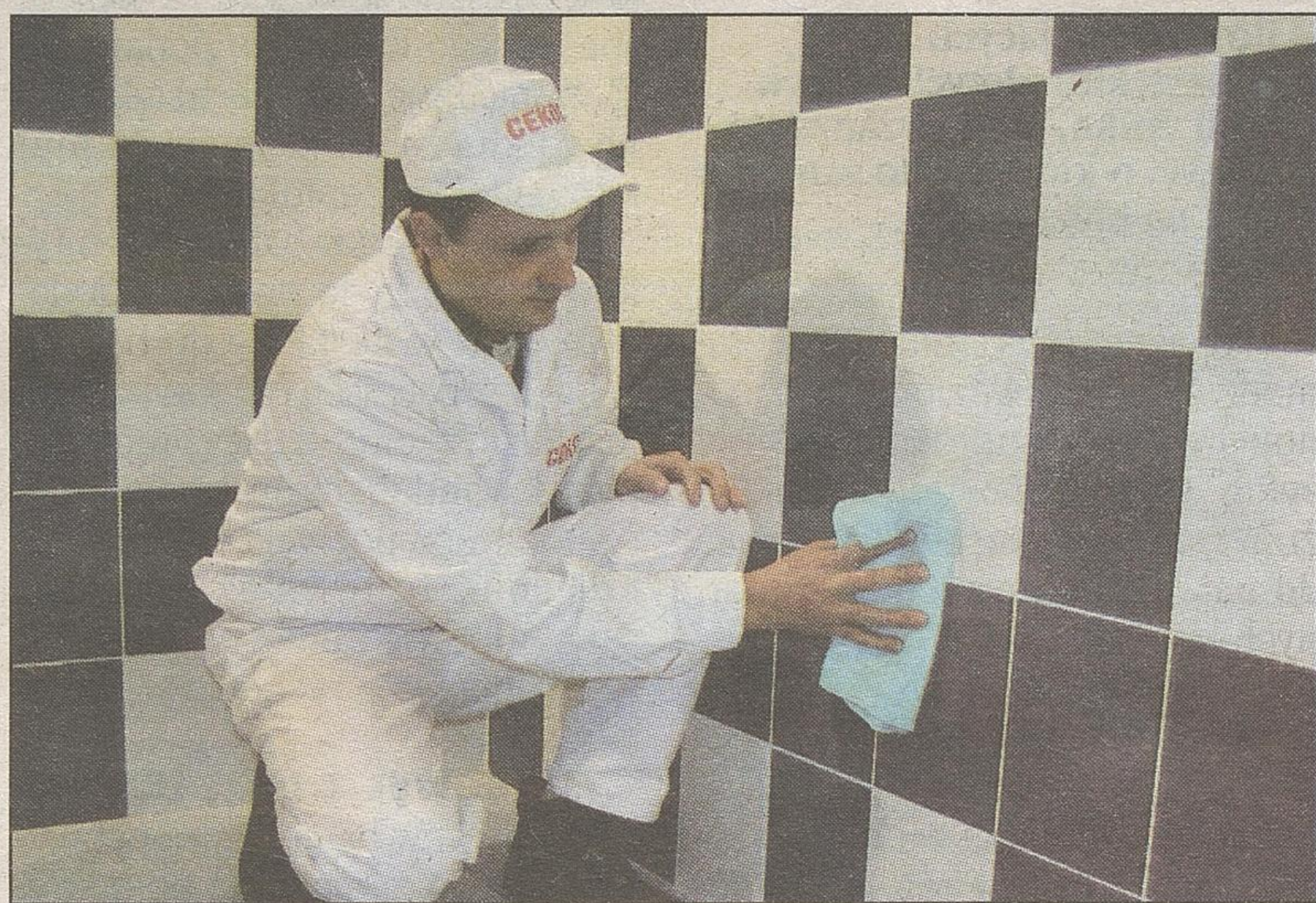
Prace zaczynamy od starannego odfłuszczenia powierzchni starej glazury
