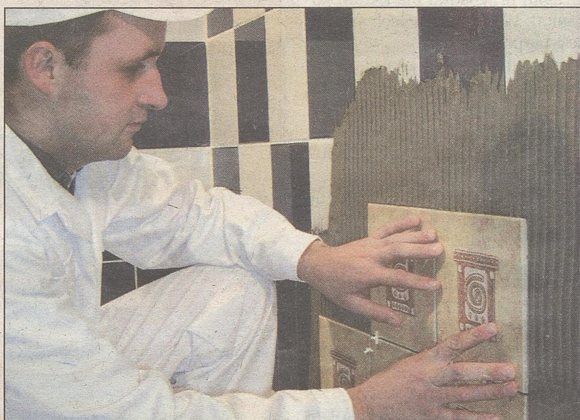
Nanosimy zaprawę na stare płytki. Grubość warstwy powinna wynosić 3-4 mm.
