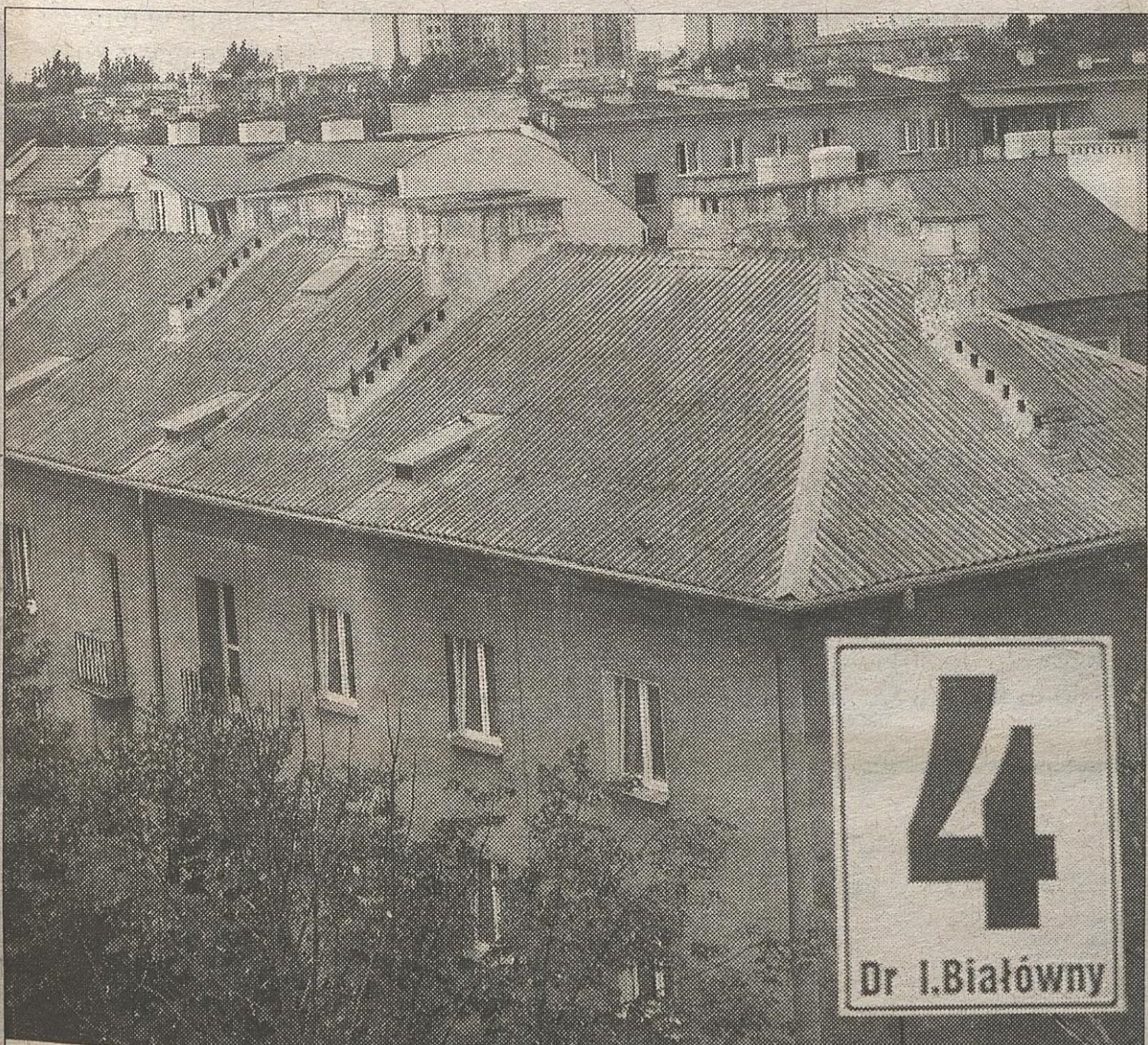
Na poddaszu budynku przy ul. Białówny 4 mają powstać trzy nowe mieszkania. Część mieszkańców nie chce się jednak zgodzić na likwidację strychu.
