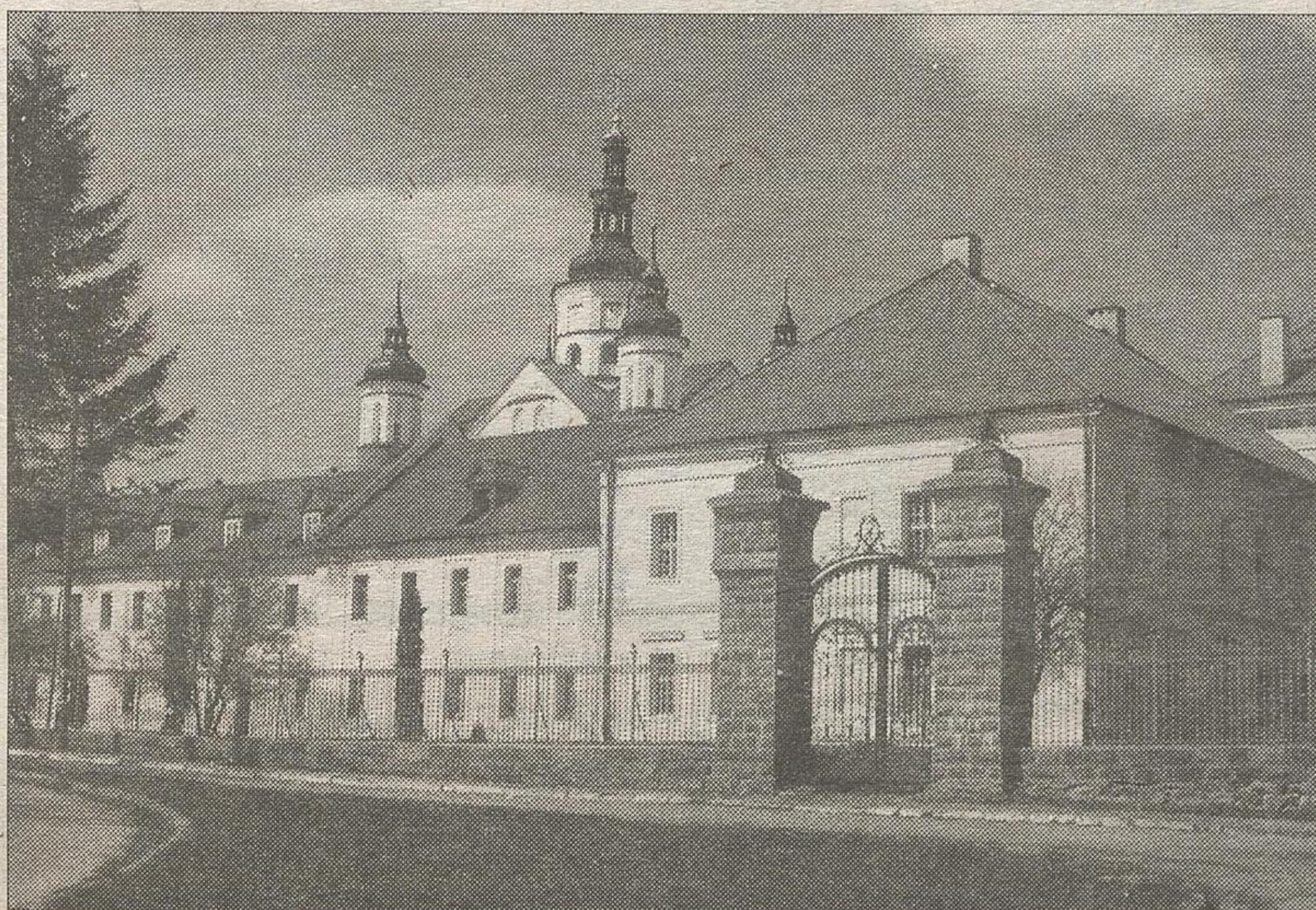
W klasztorze trzeba wykonać m.in. elewację, wymienić stolarkę okienną i drzwi. Potrzebne jest także osuszenie fundamentów.
