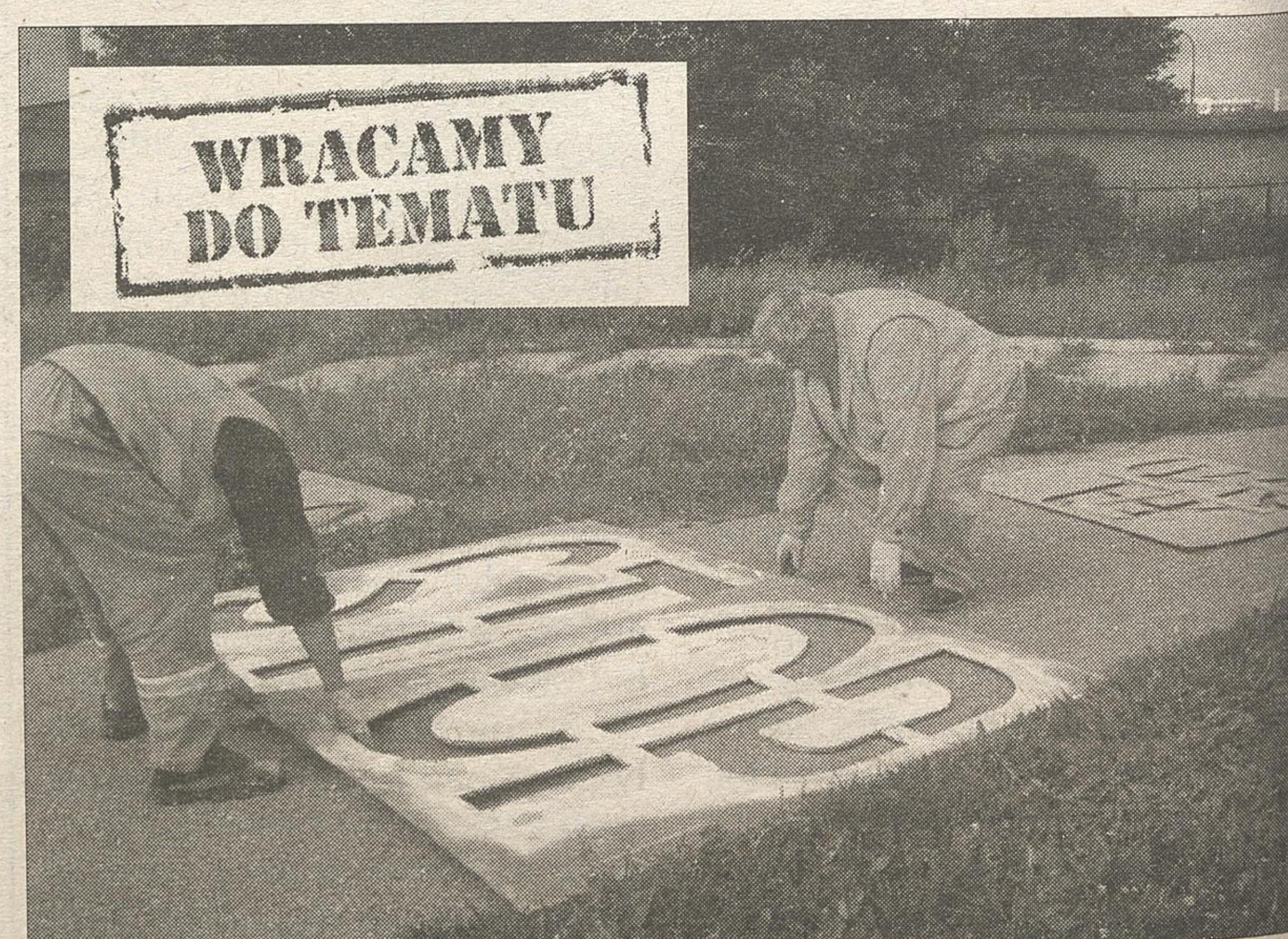
W ubiegłym tygodniu pracownicy „Budomostu” malowali na ścieżce znaki STOP – jak się okazało bezprawnie. Wczoraj musieli je ściierać.
