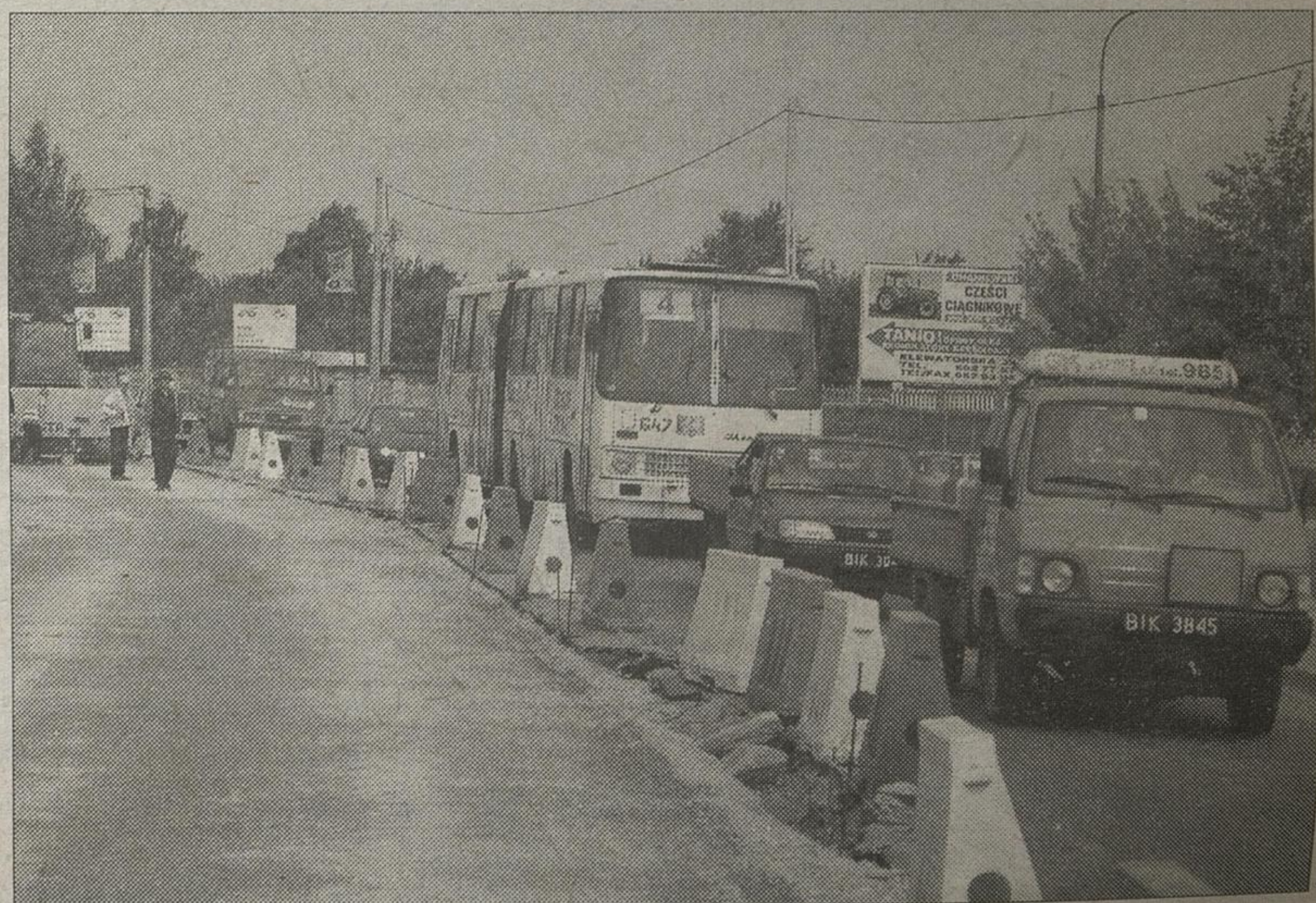
Z powodu remontu ulicy Elewatorskiej „czwórki” mają nawet kilkunastominutowe opóźnienia, bo muszą stać w korkach na remontowanych odcinkach ulicy
