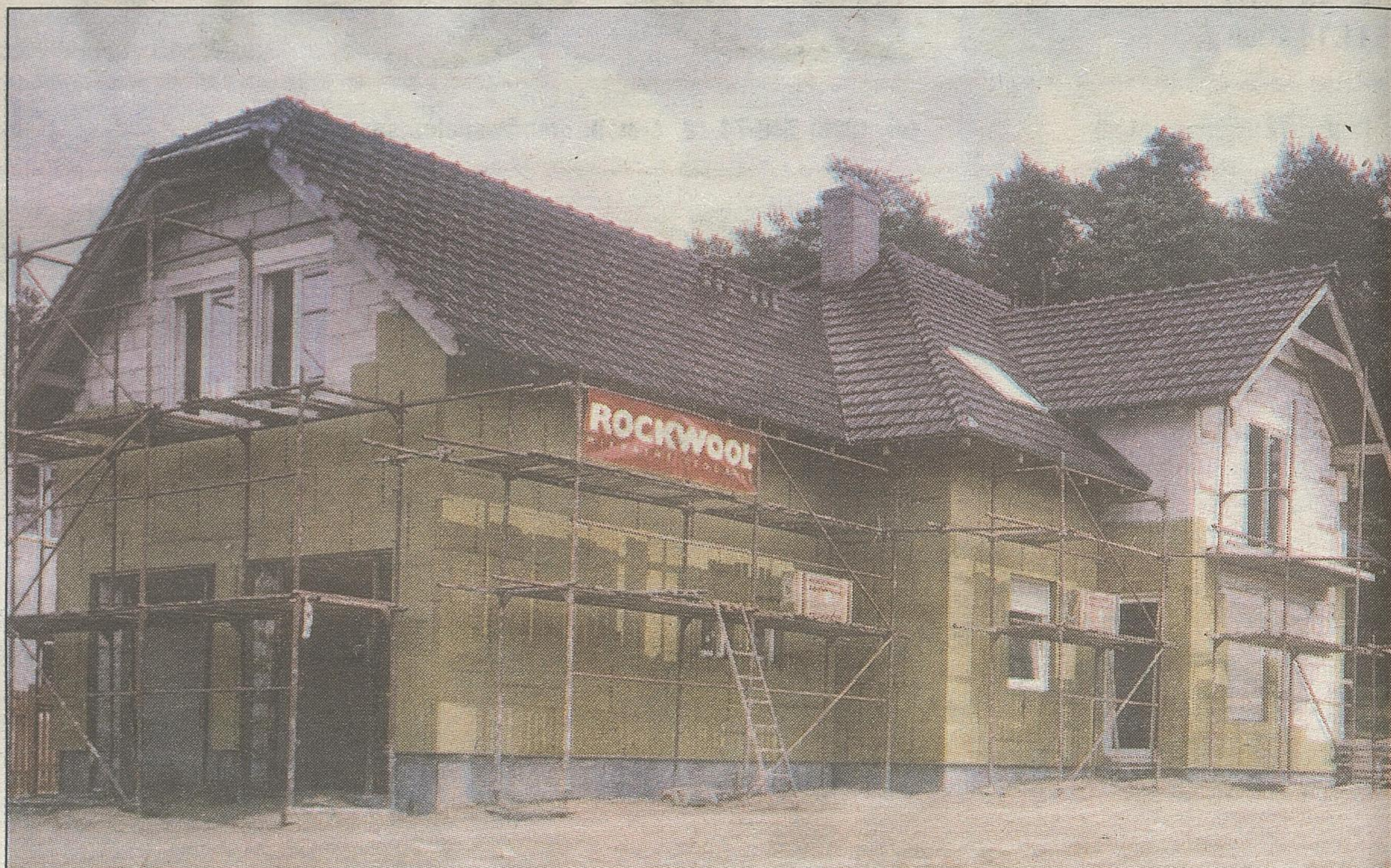
Jesień to czas, kiedy na placach budowy prowadzone są roboty dociepleniowe budynków
