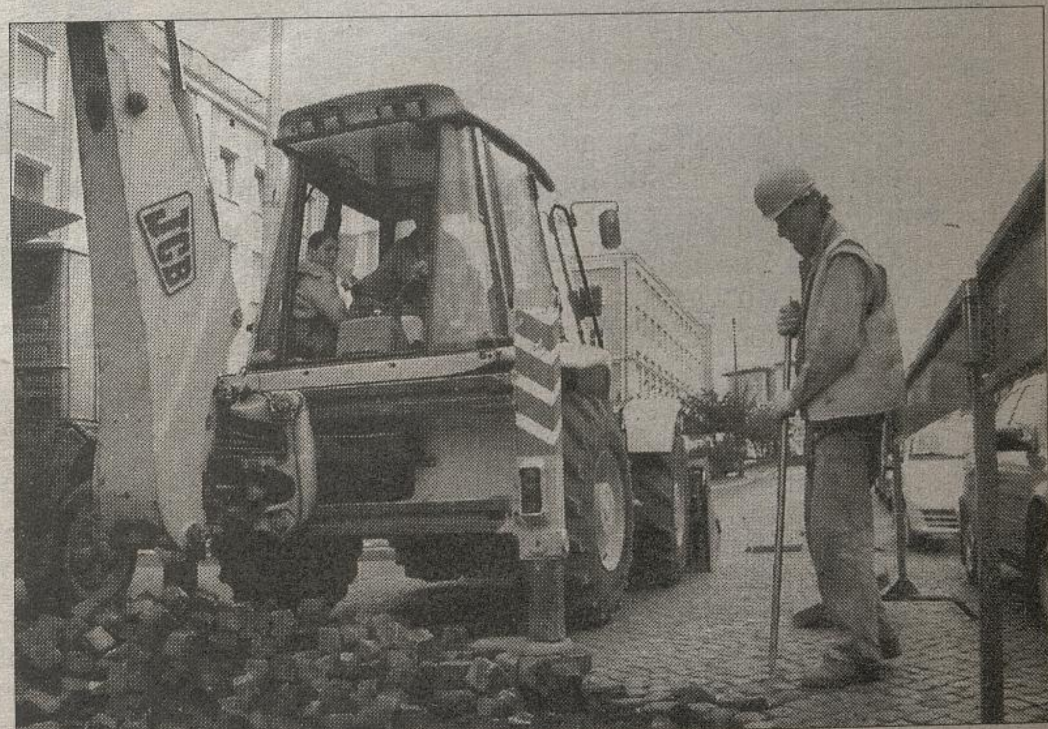
Remont rozpoczął się wczoraj także na ul. Liniarskiego – ruch w tym miejscu jest bardzo utrudniony. Kierowcy muszą pamiętać, że jest to ulica jednokierunkowa.
