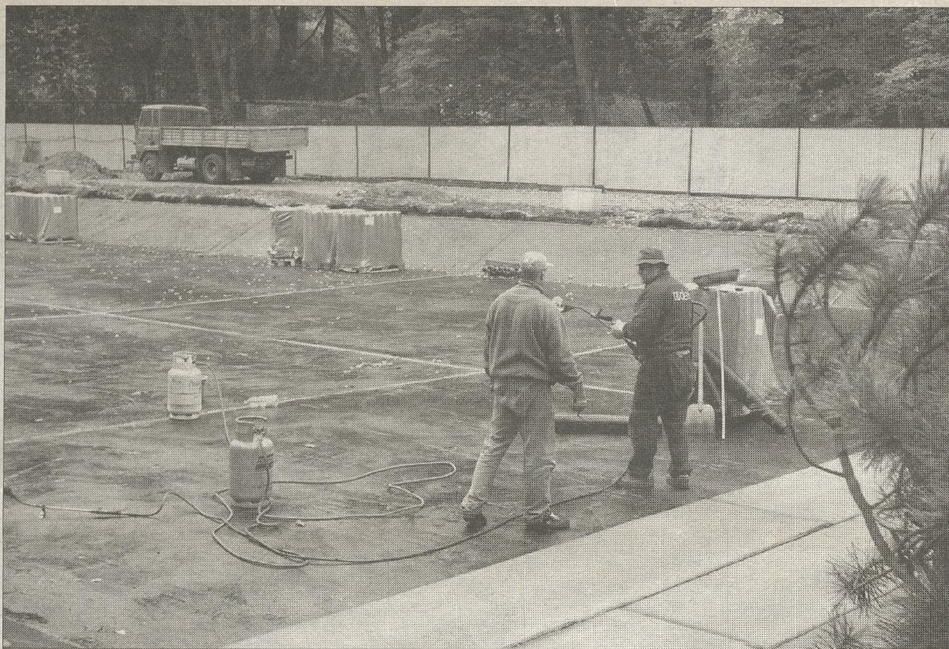
Od kilku tygodni największa miejska fontanna jest remontowana. W tym roku białostoczanie nie będą już mogli oglądać na Plantach jej kolorowych pióropuszy wodnych, gdyż remont potrwa do połowy listopada.
