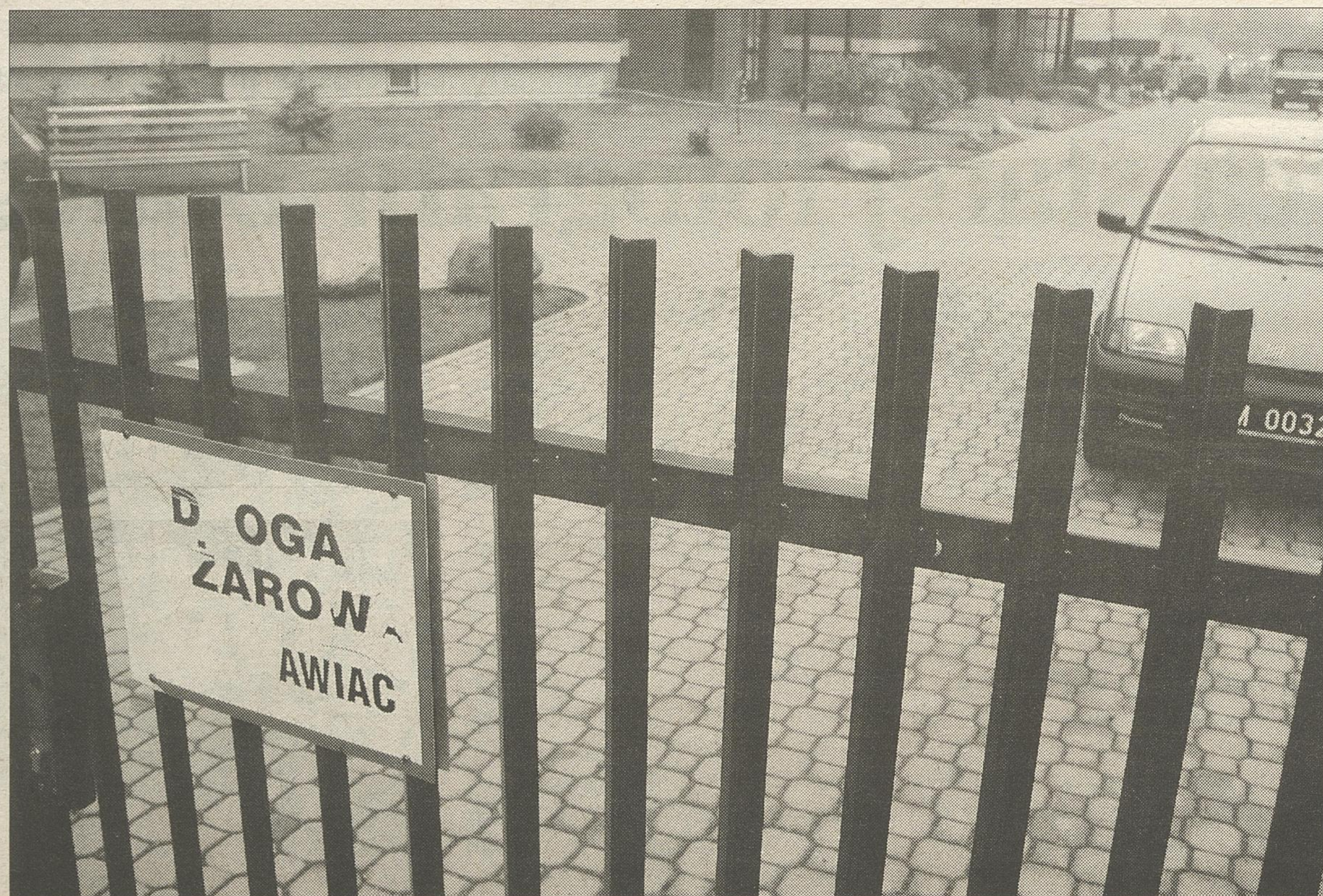
Ogrodzenie bloków przy ul. Sybiraków 7 i 9 to, jak widać, brama do drogi przeciwpożarowej. W razie pożaru można ją otworzyć. Ale... Problem w tym, że przed bramą wbite są metalowe słupki. I nic tędy nie przejdzie.
