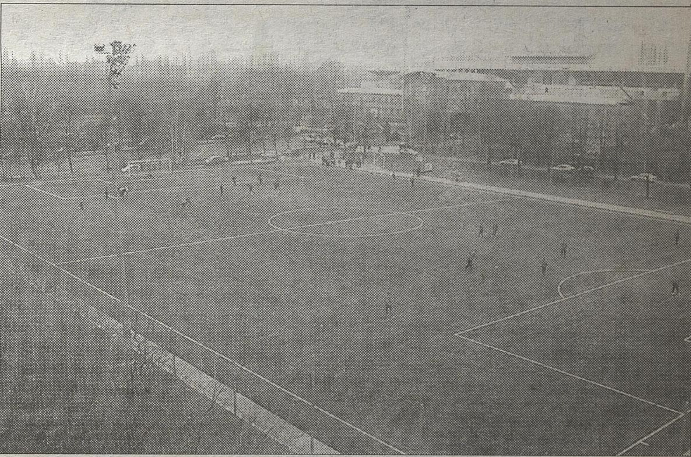
Białostockie boisko ma być podobne do tego, które powstało przy Stadionie Śląskim w Chorzowie. Jego budowa ma ruszyć już w marcu 2006 roku.
