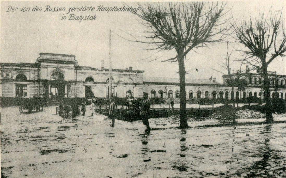
Zniszczony dworzec kolejowy w Białymstoku
