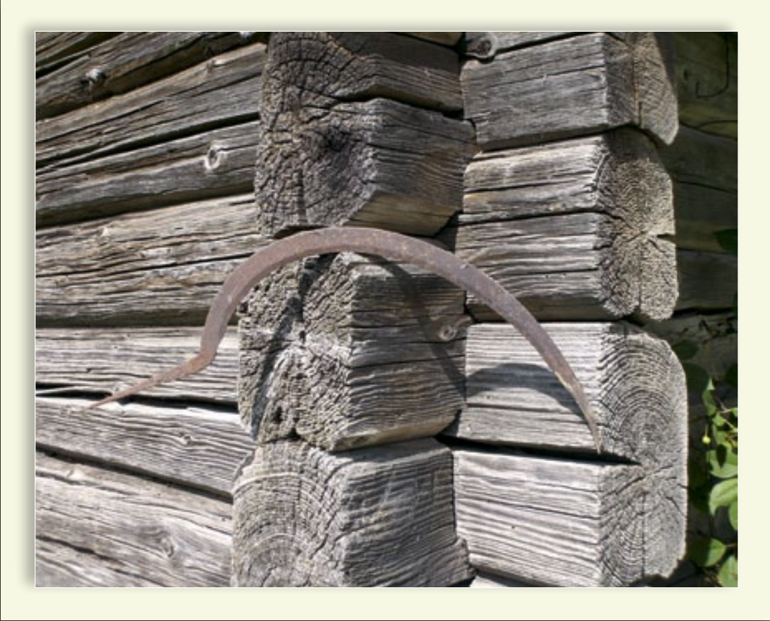
30-33. Konstrukcja zrębowa z węgiem na obłap i ostatkami / Sienų konstrukcija su nelygiomis dvipusių išpjovų kertėmis, Poškonys
