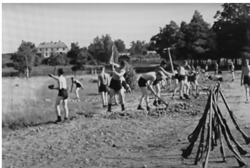
Prace oddziału 104. przy budowie drogi w Białowieży, z prawej karabiny ustawione w kozły, na wypadek ataku partyzantów. W głębi były budynek Nadleśnictwa Białowieża (kadr z filmu „Naer...”)
