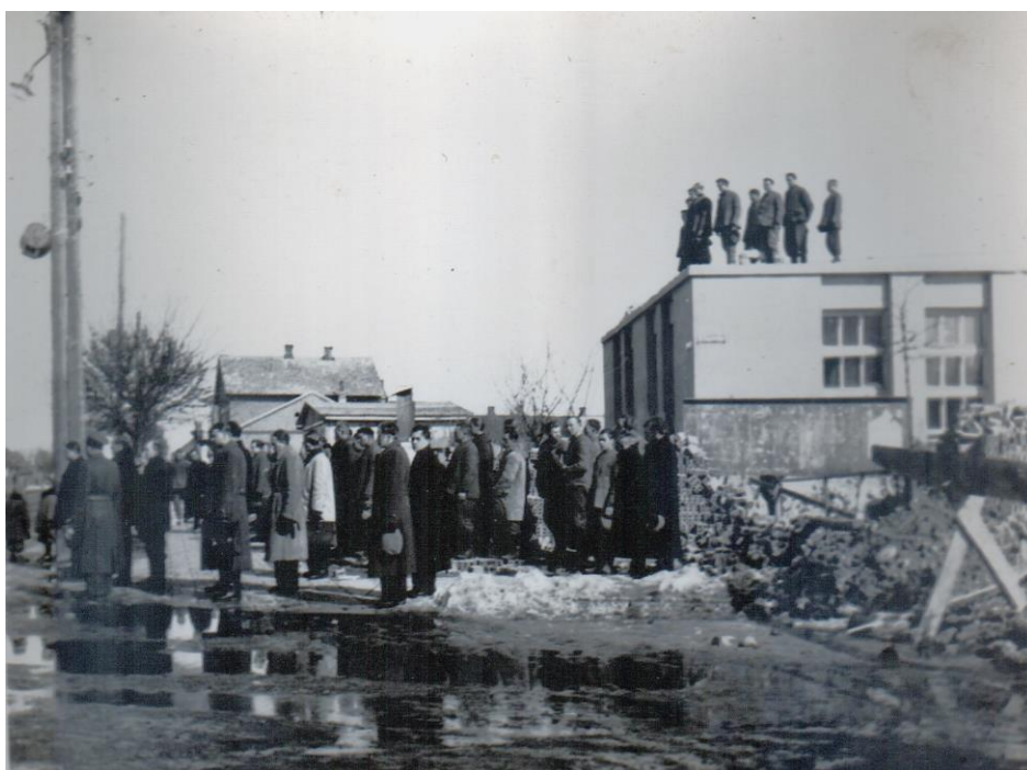
Bielsk Podlaski, prawdopodobnie marzec 1956 r. Przebudowa byłej sali obrad Urzędu Gminy, w lewe skrzydło budynku Prezydium PRN (zdjęcie ze zbiorów A.M. Łęczyckiego)
