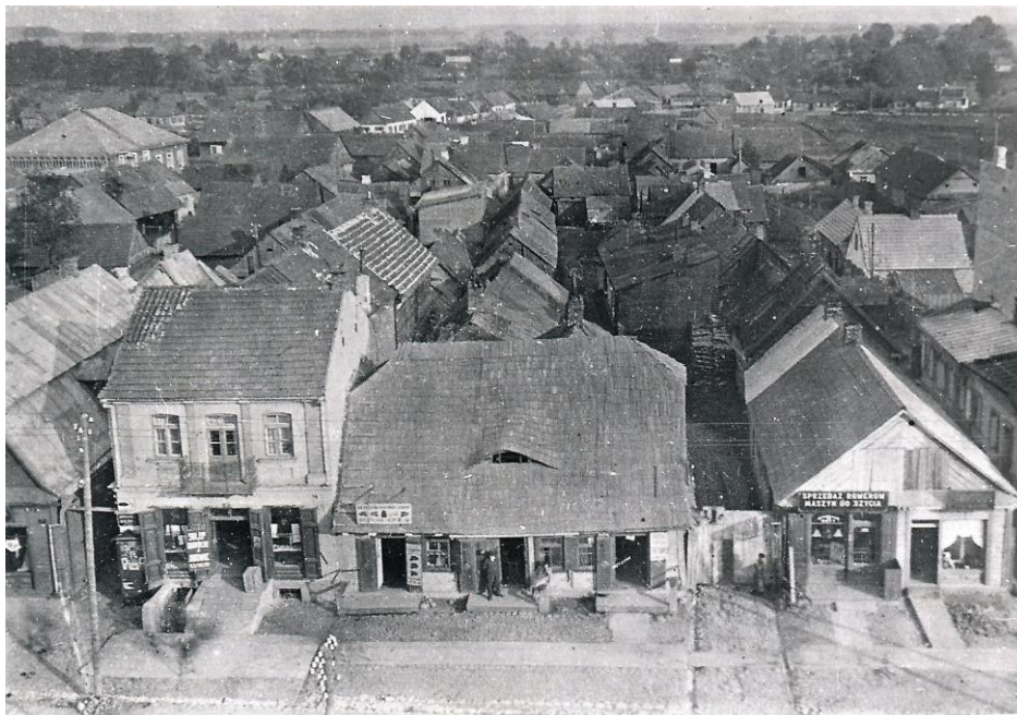
Widok z wieży ratusza na zabudowaną dzielnicę żydowską. Tutaj Niemcy w 1941 r. urządzili getto. Z lewej strony, w głębi, bożnica „Bramy Syjonu”. Fot. z 1930 r. (ze zbioru rodz. Pokoniewskich)
