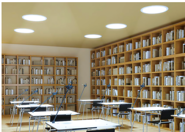
RYS. 12. Zastosowanie świetlików rurowych w budynku publicznym (bibliotece)
