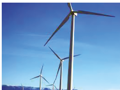
RYS. 14. Turbina wiatrowa pozioma trzyłopatowa
