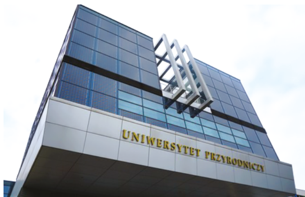
RYS. 9. Ogniwia fotowoltaiczne na fasadzie budynku
