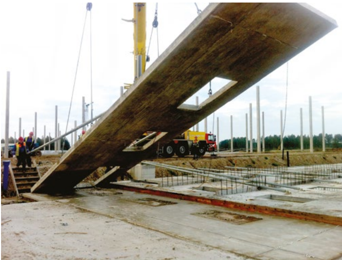
PAV. 8.3. „Tilt – up“ panelė (Šaltinis: asmeninis archyvas, 2018)
