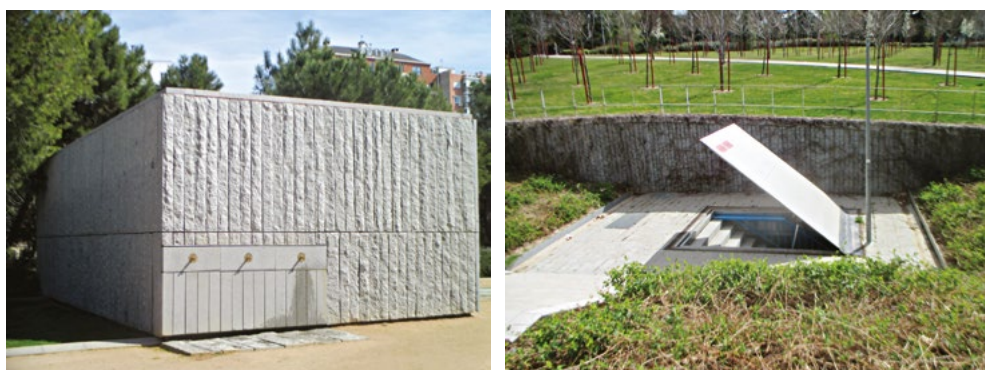
FIG. 4.10. Proyecto Madrid-Río, pequeños objetos situados en nuevos espacios públicos, en Madrid, España. Izquierda: Infraestructura con acabado en granito y fuentes. Derecha: Salida de emergencia del túnel inferior (Fuente: M. A. Flórez de la Colina, 2019)
