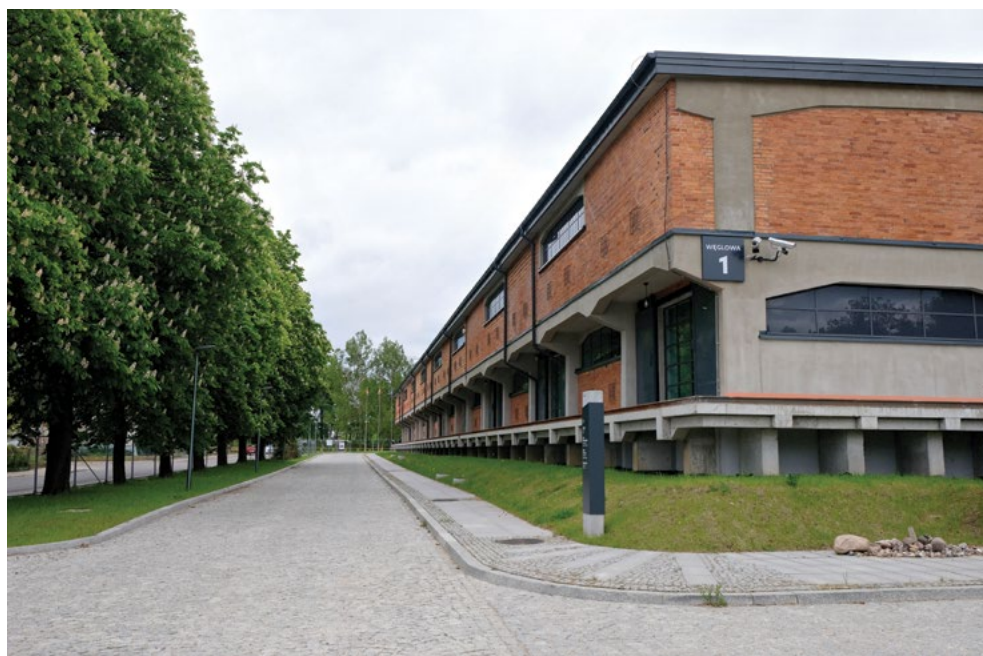
Rysunek 2: Magazyny na ul. Węglowej w Białymstoku po rewitalizacji
