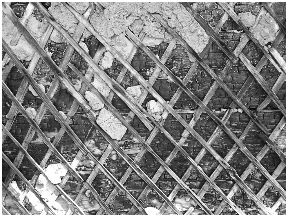
Ryc. 40. Tynk na listwowaniu, chroniący drewnianą ścianę; fot. studenci WA PB (z archiwum Wydziału)
