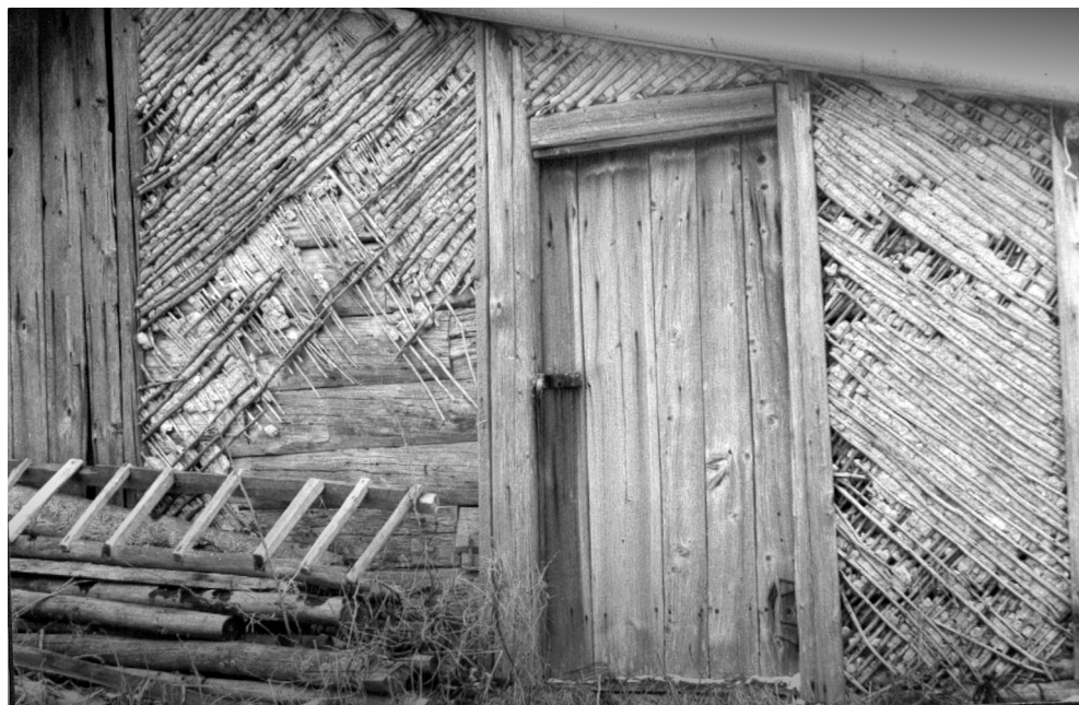
Ryc. 41-42. Tynk na listwowaniu, chroniący drewniane ściany; fot. studenci WA PB (z archiwum Wydziału)
