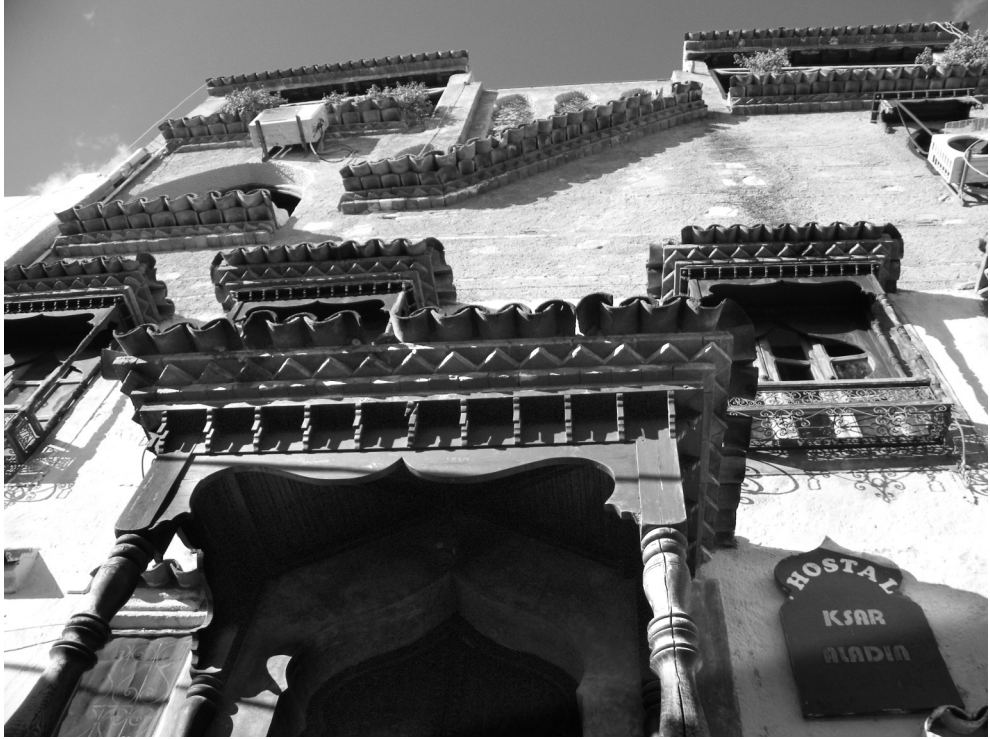
Ryc. 53. Ceramika (dachówki i płytki azulejos ) osłaniające od dżdżów budynek w marokańskim mieście Fez; fot. autor, 2010
