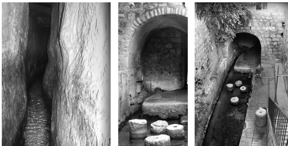
Ryc. 43. Tak zwany Tunel Ezechiasza w Jerozolimie, długi na 533 metry, wykuty w skale w VIII wieku p.n.e. i odtąd współfunkcjonujący z jeszcze starszym systemem krótszych naturalnych i sztucznych kanałów pod miastem; fot. autor, 2008
