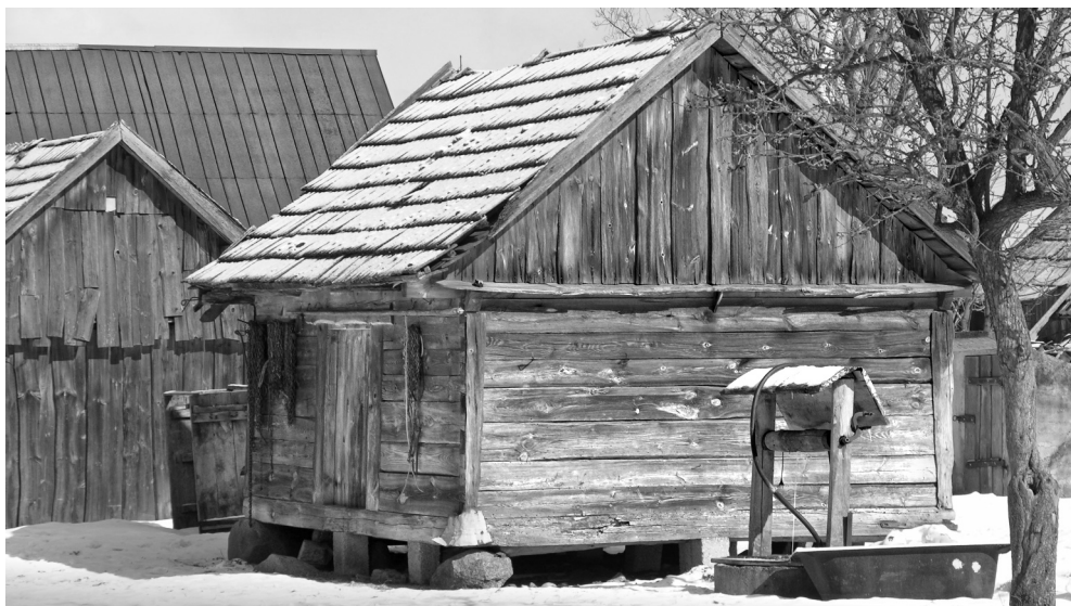
Ryc. 37. Drewniany spichrz w Zagruszanach, posadowiony na kamieniach dla odciążenia migracji wilgoci i zapewnienia przewiewu podpodłogowego; fot. studenci WA PB (z archiwum Wydziału)
