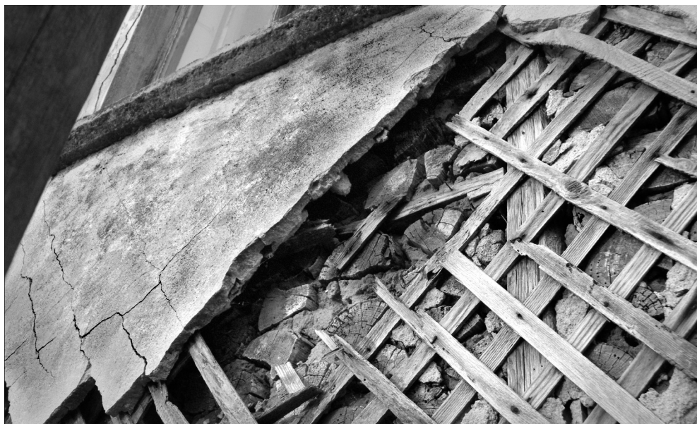
Ryc. 10. Tynk dystansowy na glinodrewnianej chałupie w Mieleszkach na Białostocczyźnie; fot. autor, 2008
