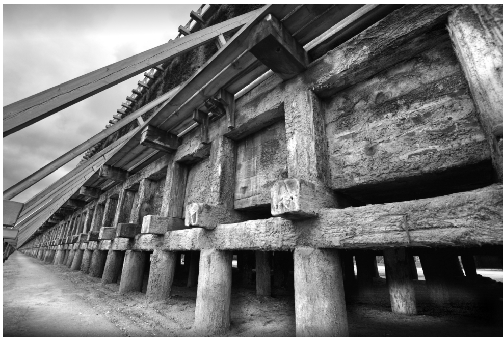
Ryc. 8. Drewniany fundament palowy tężni w Ciechocinku (z lat 1824-1828); fot. autor, 2018
