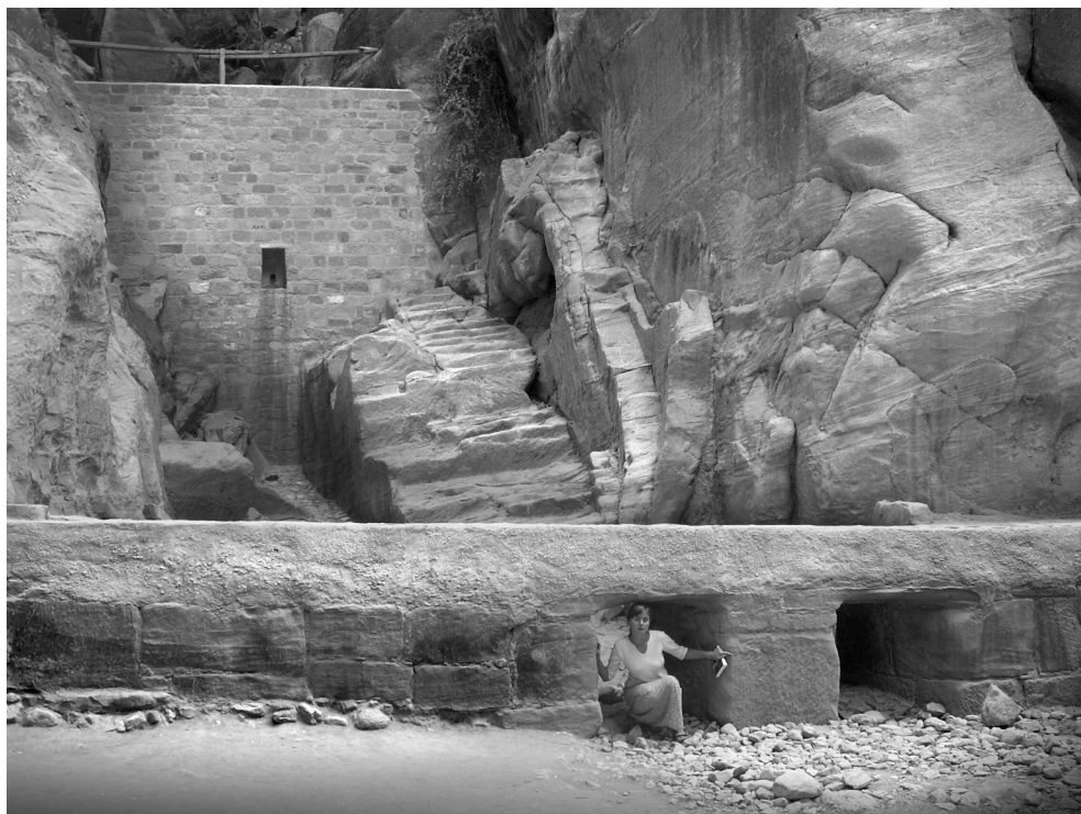
Ryc. 13. Poziomy otwarty kanał wodociągowy z I wieku n.e w starożytnej Petrze, nabatejskim mieście wykutym w skale, obecnie na terenie Jordanii; fot. autor, 2008
