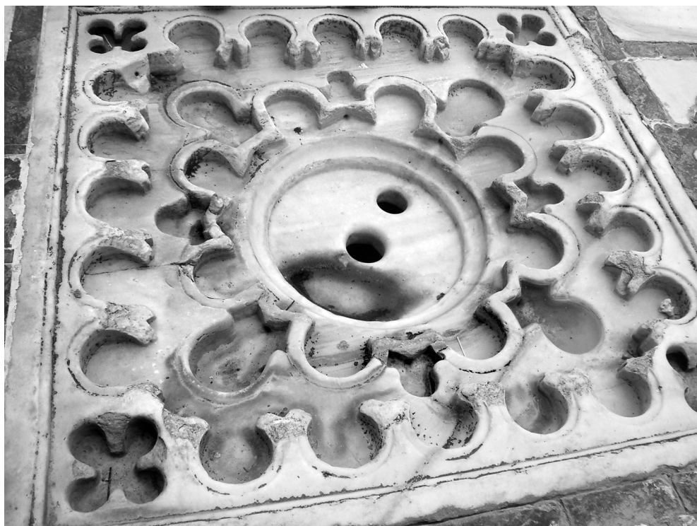
Ryc. 22. Łapacz deszczówki nad podziemną cysterną meczetu w Kairouanie; źródło: Wikimedia Commons: https://commons.wikimedia.org/wiki/File:Col%C2%B7lector_d%27aig%C3%BCes_-_Gran_Mesquita_de_Kairuan.jpg , fot. Jaume Ollé, 2007
