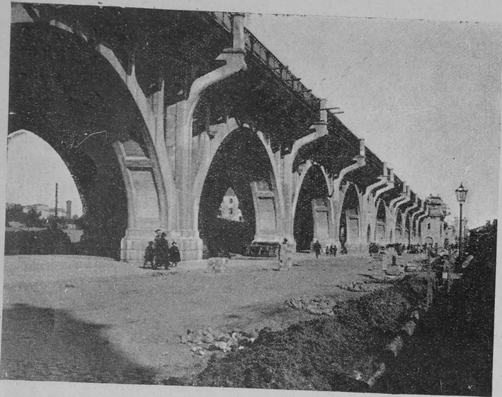
Wiadukt trzeciego mostu.
