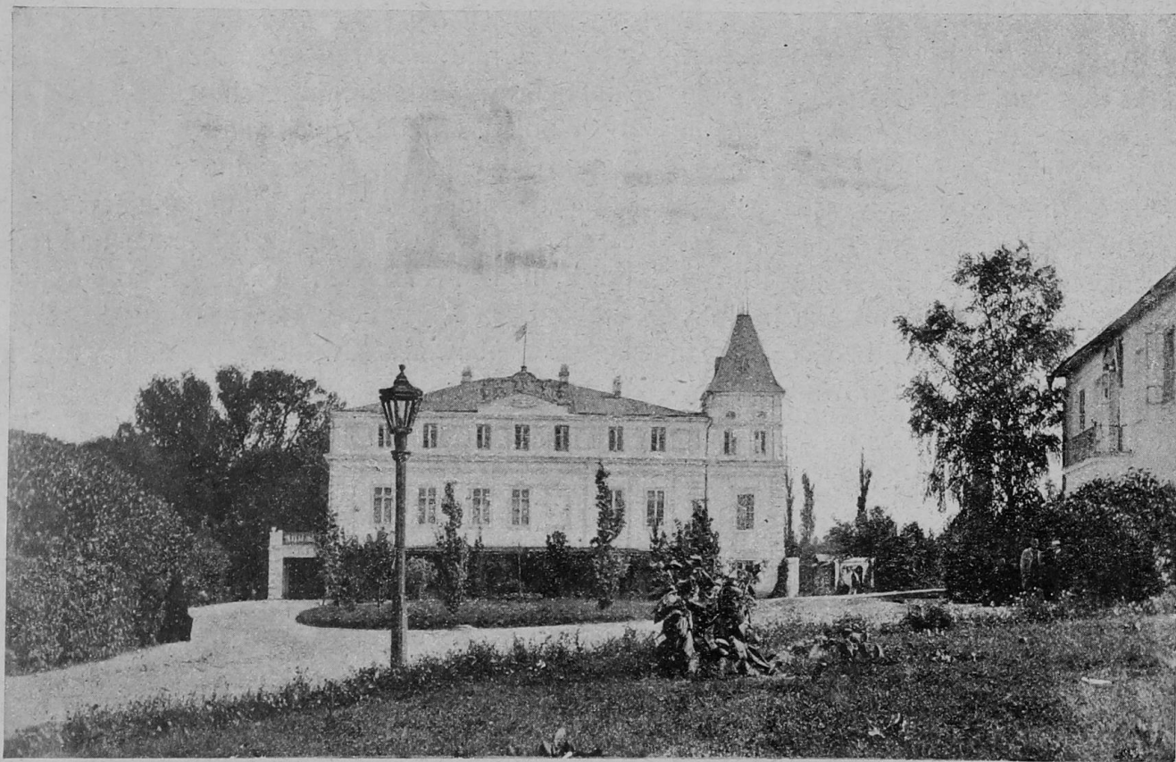
Pałac w Nałęczowie, zbudowany przez Stan. Małachowskiego w r. 1773.
