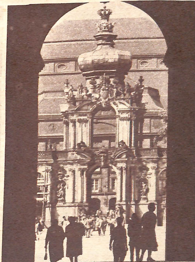
Fragment odbudowanego zabytkowego pałacu „Zwinger” w Dreźnie
