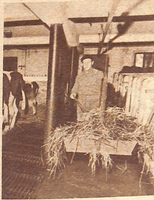
Oto obora bezściółkowa, z metalowymi rusztami nad kanałem zbiorczym.
