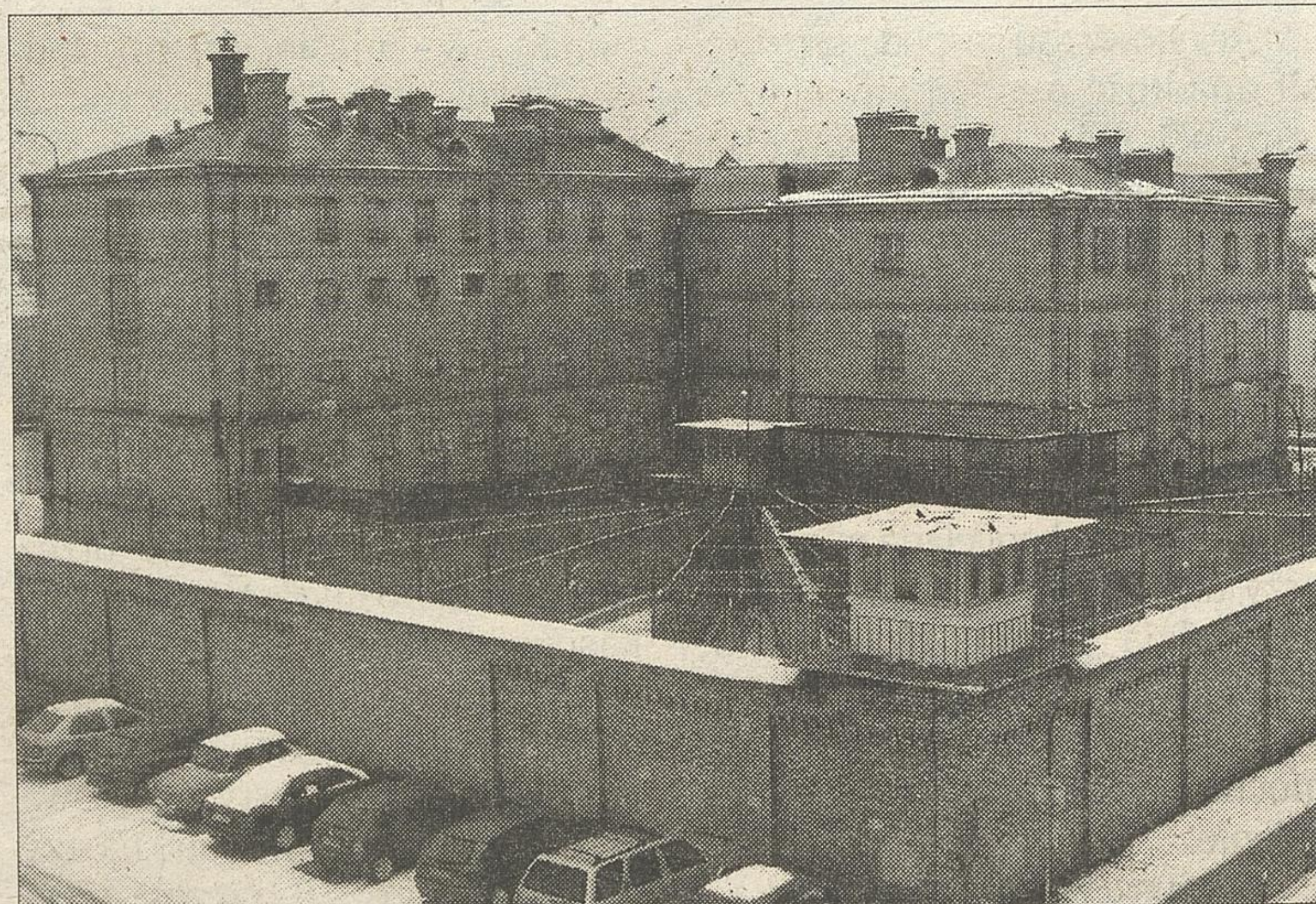
Nowa kamera obejmie część osiedla przy ul. Bema, ale także okolice aresztu śledczego
