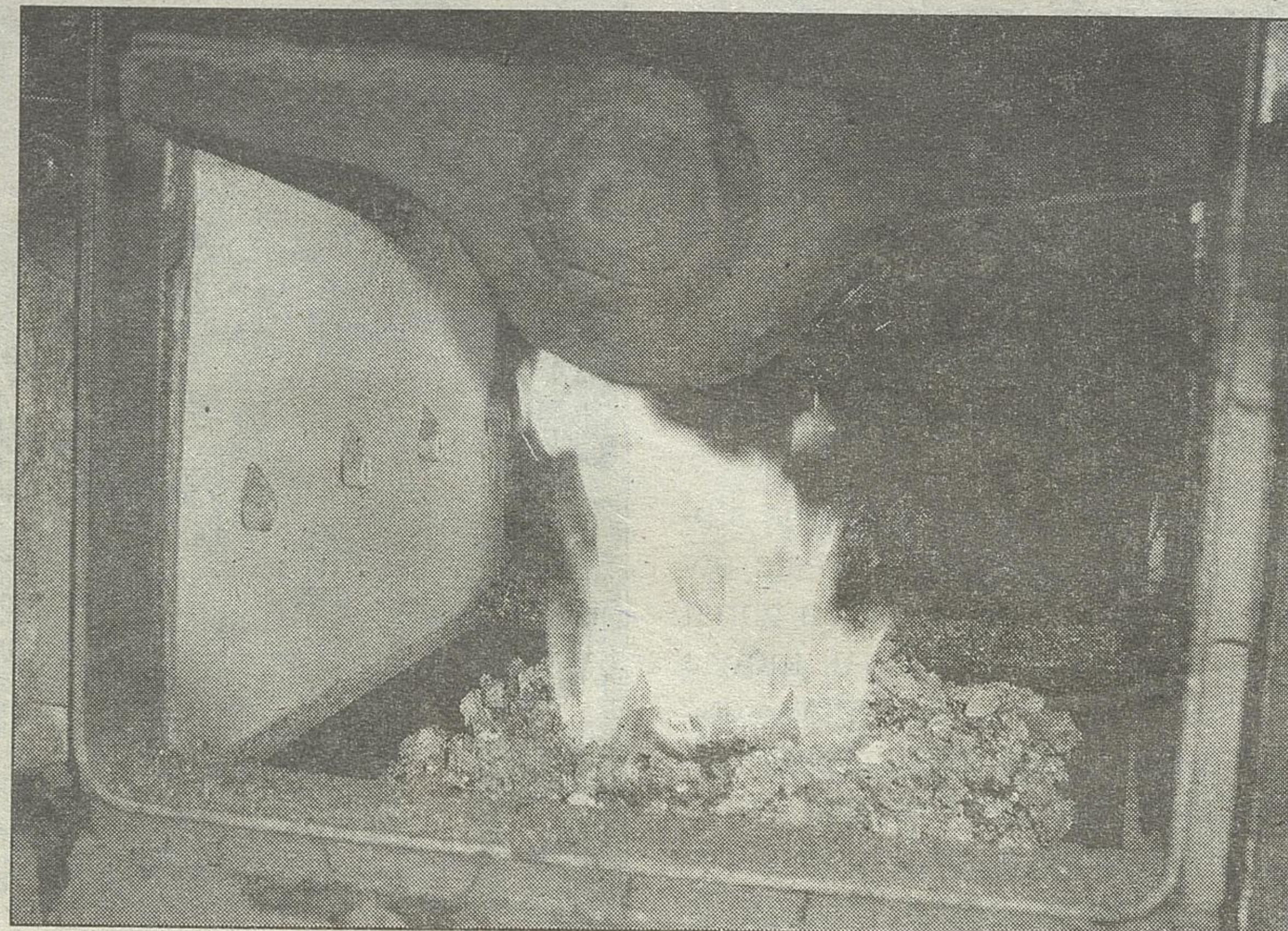
Zasada działania palnika wygląda następująco: ślimak podajnika wypycha węgiel na palenisko od dołu. Na górze węgiel się spala, a pozostałości są zdmuchiwane na boki i trafiają do popielnika.
