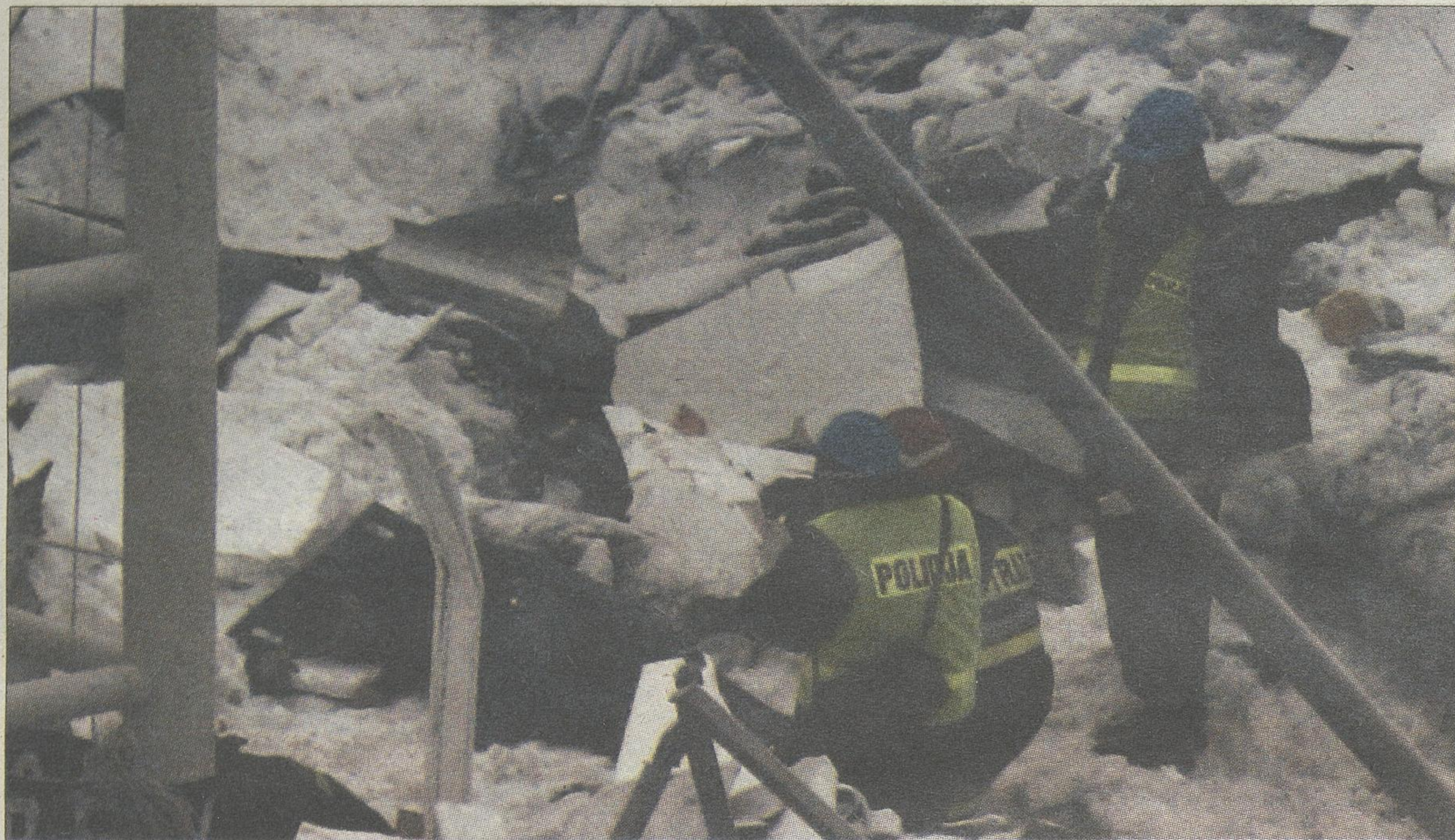
Ciało 65. ofiary ratownicy znaleźli w odległości około 2 m od odsłoniętej wcześniej części posadzki hali
