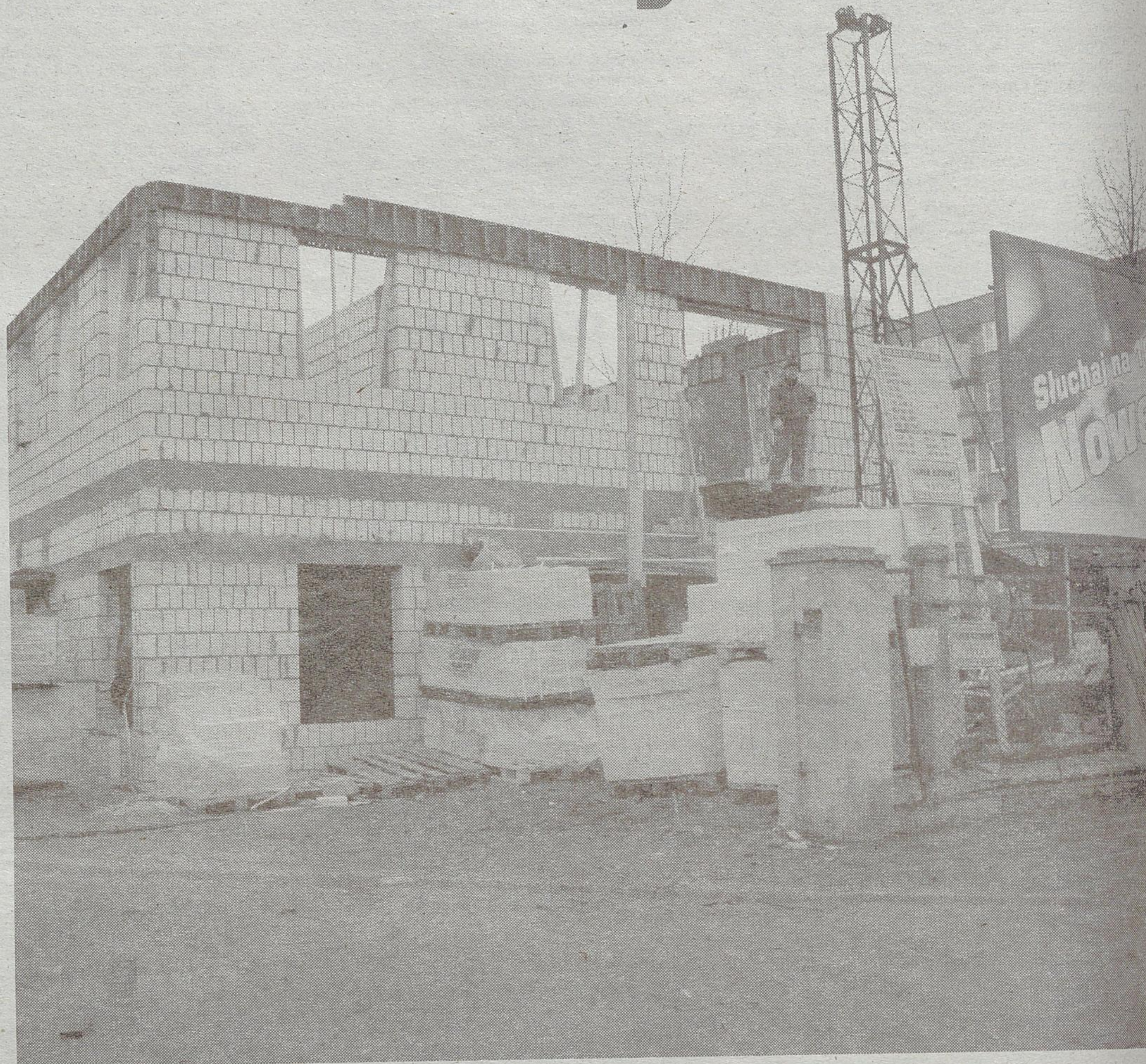
Oznaczenie terenu budowy należy do obowiązków inwestora
