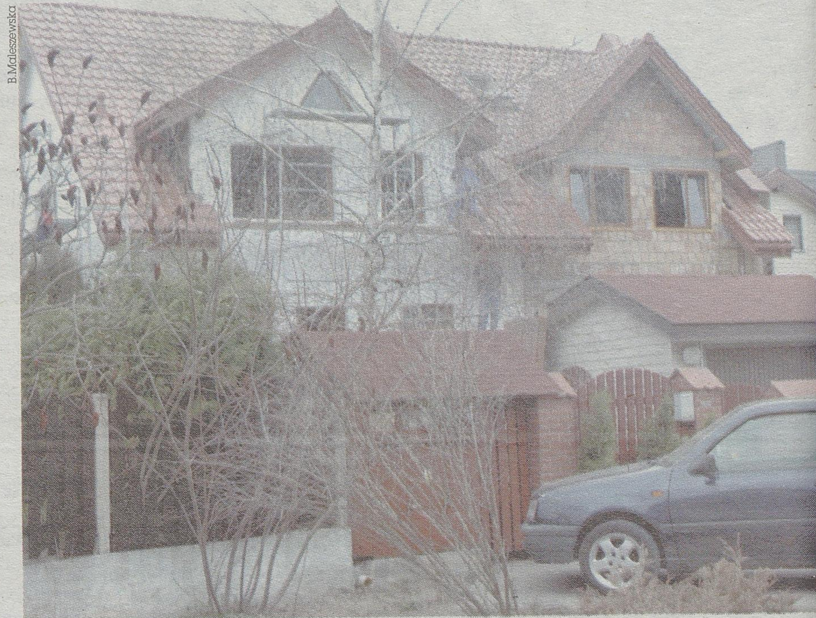
▲ Właśnie trwa odbudowa jednego ze spalonych domów w Sochoniach
