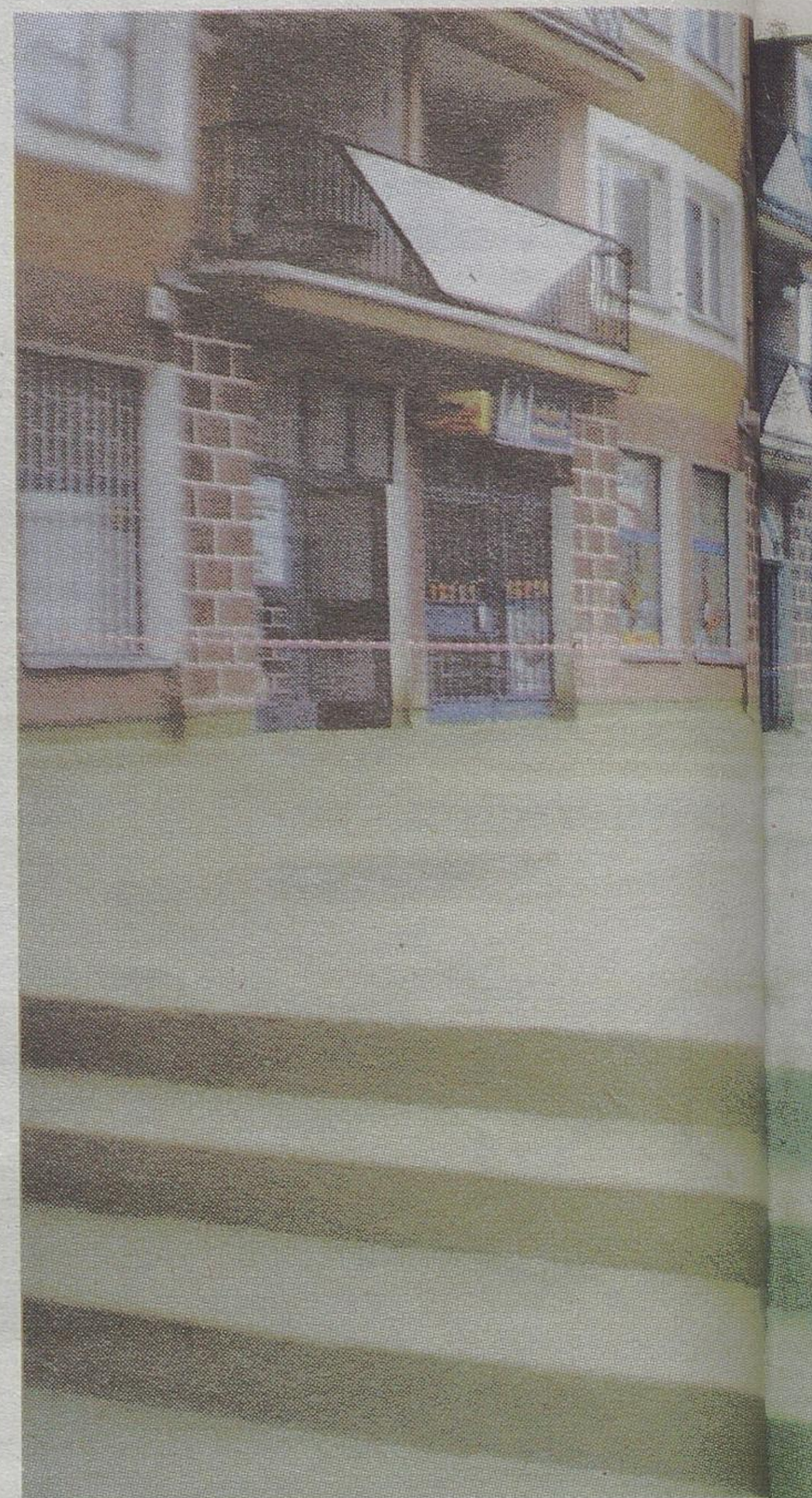
Taras w Elku nad garażami podczas wykonywania natrysku hydrobestem – jedna z realizacji z użyciem nowego środka
